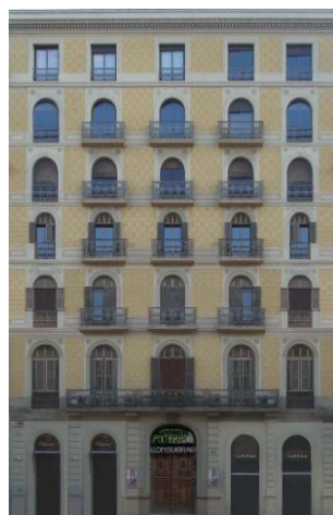
Figura 4.24: Edifici amb una remunta que segueix l'estil inicial. Passeig de Gràcia, 78. Font: Projectes de catalogació del Dep. EGA II.
