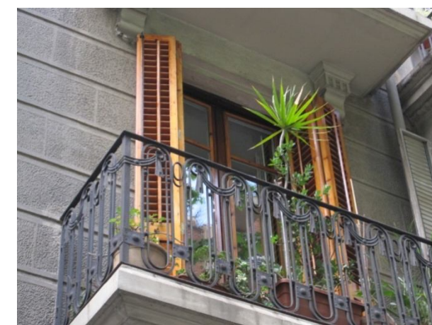
Figura 4.27: Detall de persianes de llibret i marcs restaurats sense seguir una coherència estètica (color blanc) amb la resta de fusteries. C/ Concell de Cent, 245. Font: Elaboració pròpia.
