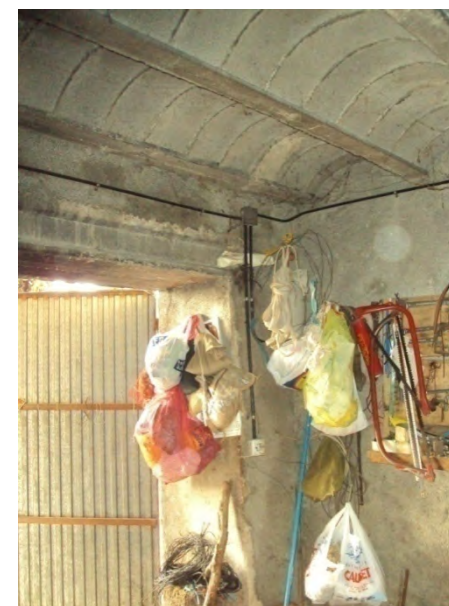
7.2.2.3/1. S'observa les bigues de formigó i el revoltó de formigó del forjat de la planta primera de la casa
