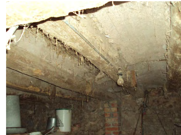
9.2.3/23. Presència de brutícia en la part inferior del forjat
