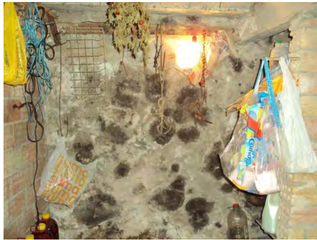
7.2.2.2/1. S'observa una paret de càrrega de la casa sense revestiment
