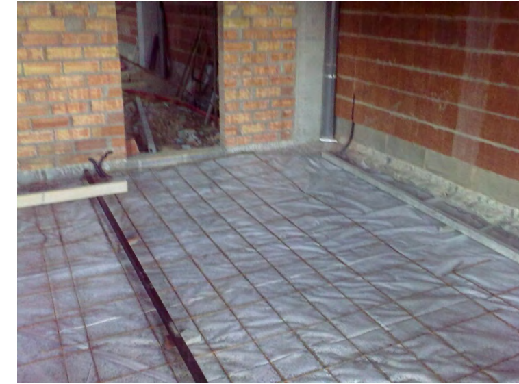
13.2.6/1. Imatge feta per l'autor on s'observa la col·locació de la barrera amb una membrana plàstica i al damunt la malla electrosoldada
