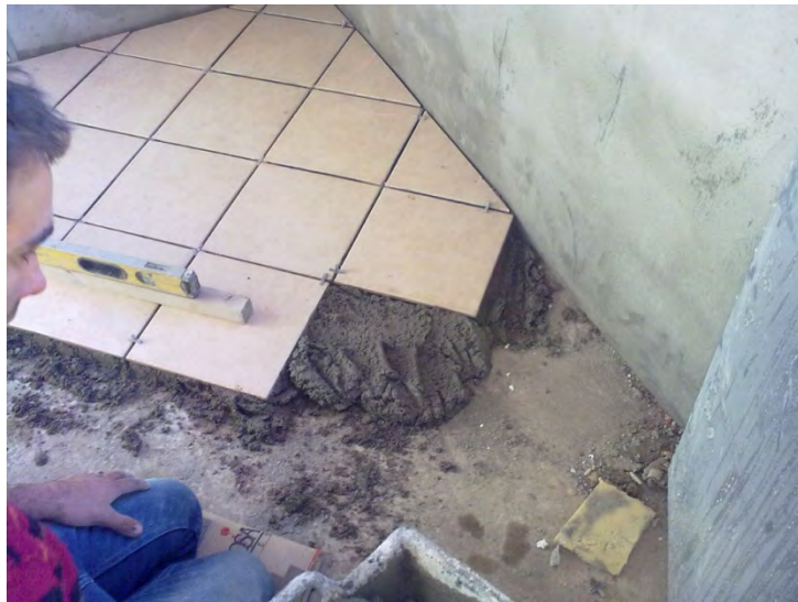
13.2.6/3. Imatge feta per l'autor de l'execució del paviment de gres amb la capa de morter de ciment.
