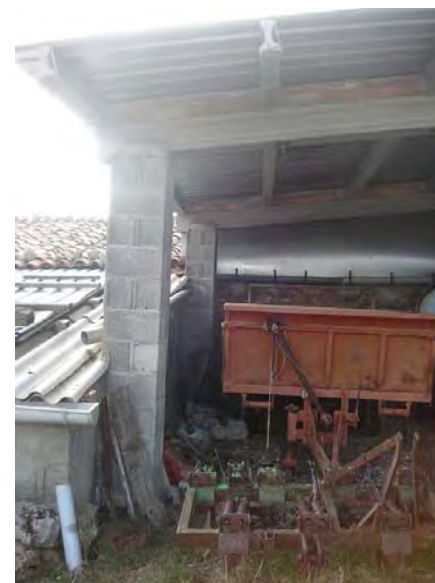
7.2.2.2/8. S'aprecia els pilars de blocs de formigó en la part posterior de la casa
