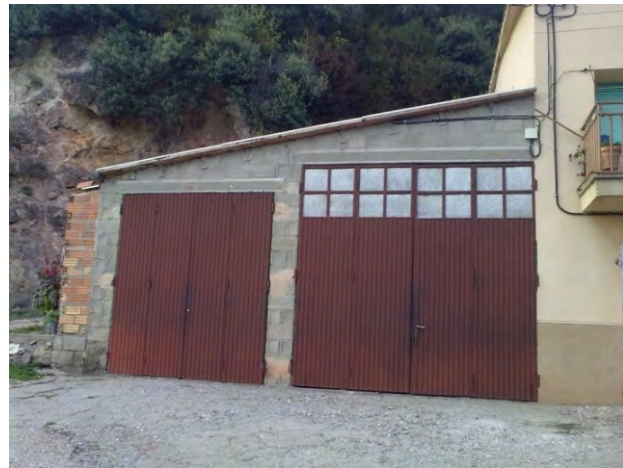
7.2.3/1. Façana garatge "A" s'aprecia l'estructura de blocs de formigó
