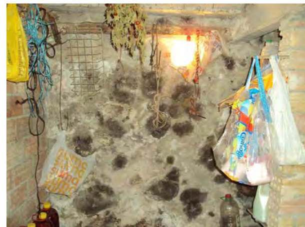
9.3/9. S'aprecia la humitat manifestada en la part inferior de l'escala
