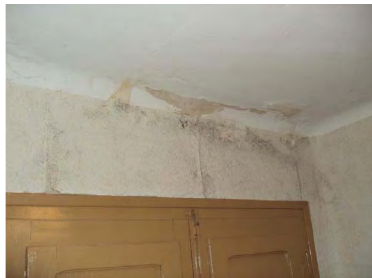
9.2.2/21. Despreniment del paper i la pintura en la part superior de la finestra
