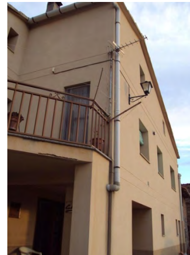
7.2.5/5. Revestiment morter monocapa de la façana de la casa
