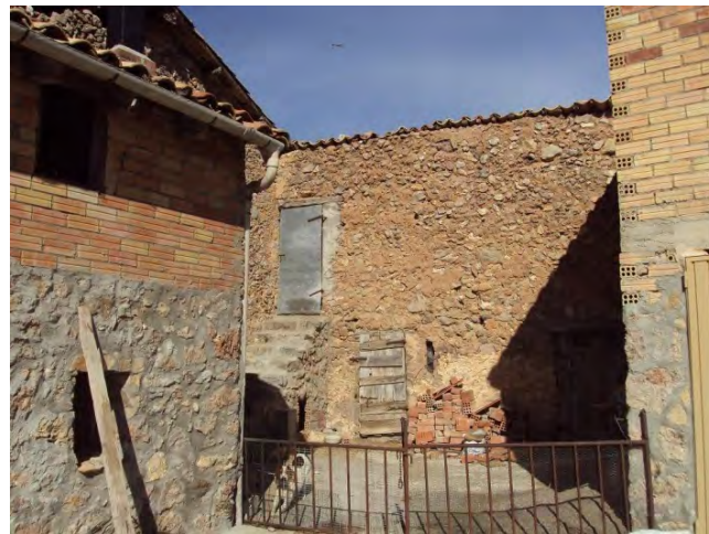
7.2.3/3. Façana Pallera realitzada amb mamposteria i sense revestiment
