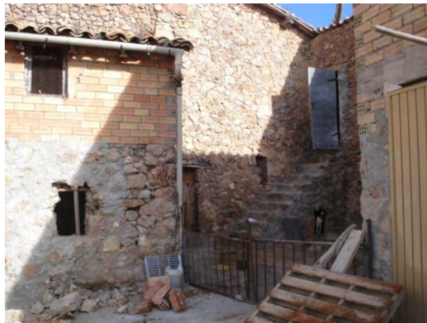
7.2.2.3/3. S'observa l'escala d'accés en la primera planta de la paller
