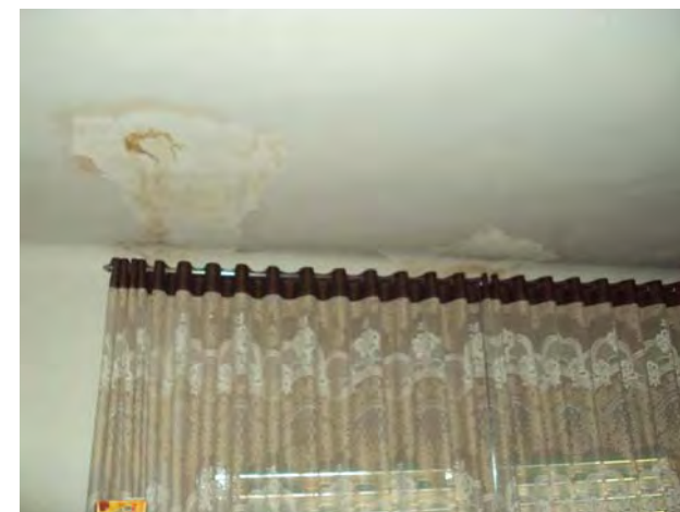
9.2.3/10. S'aprecia les taques de filtració d'aigua de pluja de la façana Sud
