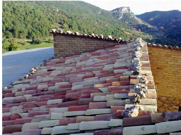
7.2.3/6. Estat de la coberta de la Pallerà vista de dalt
