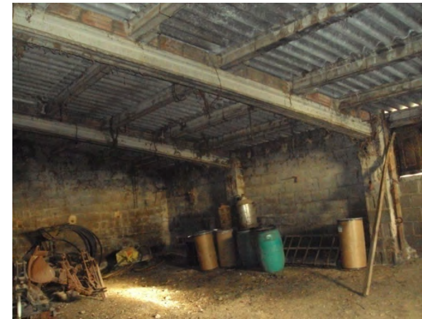
7.2.2.2/3. S'aprecia l'estructura vertical del corral 5
