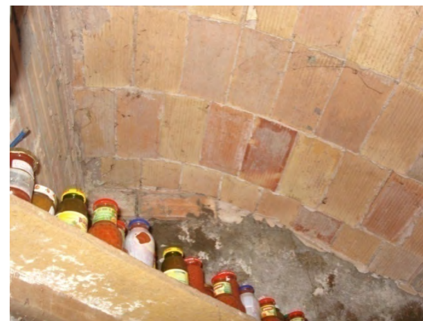
7.2.2.3/4. S'aprecia els maons que conformen la volta de l'escala de la casa
