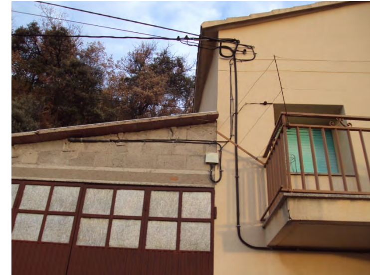
13.2.7/5. Escomesa aèria en la façana principal, foto realitzada abans de la intervenció.
