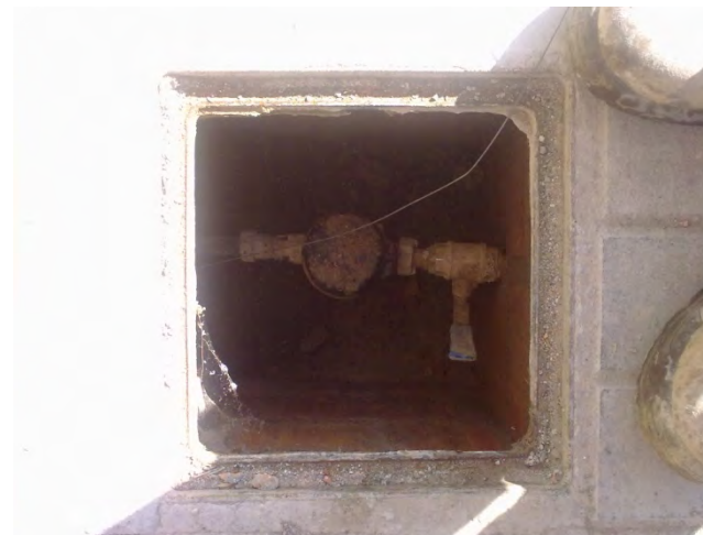
13.2.7/4. Fotografia feta per l'autor d'arqueta de registre amb clau d'abonat i un comptador.
