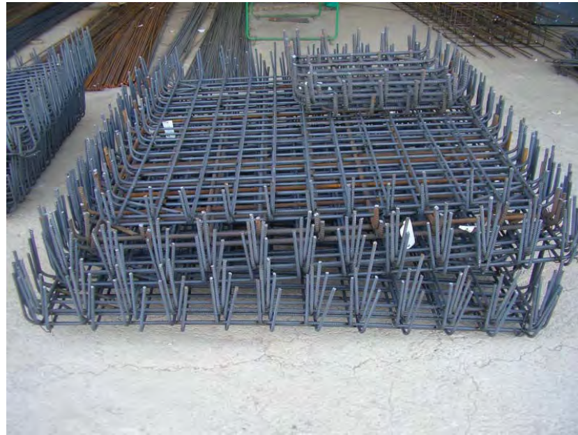
13.2.3.1/1. Imatge realitzada per l'autor d'enllaç de barres corrugades per l'execució de pous.
