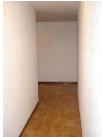
7.2.5/4. Planta primera de la casa, s'observa el paviment ceràmic
