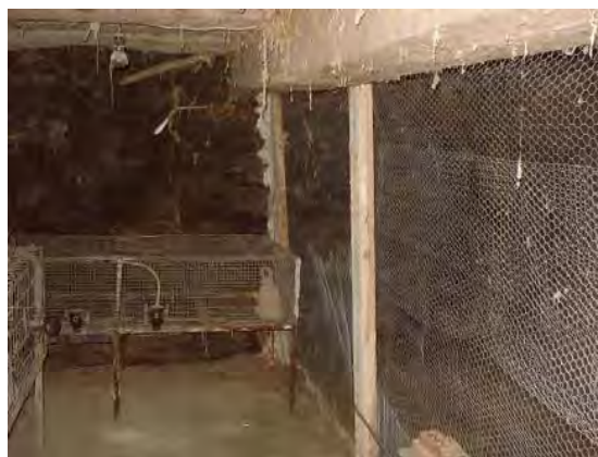
9.2.3/8. Apuntament d'urgència en una biga del corral "2"
