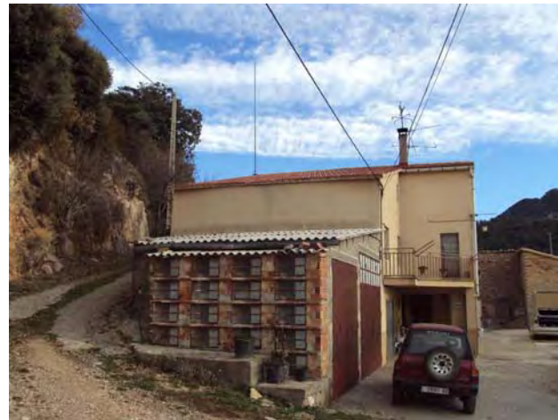
7.2.3/9. Vista Oest del garatge "A" on s'observa la coberta d'uralita
