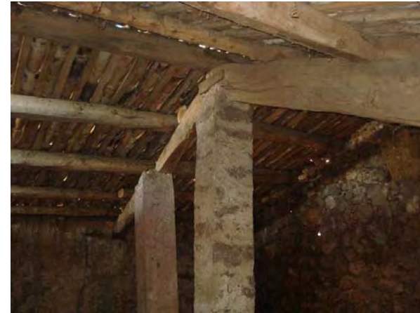
7.2.3/7. Subjecció inferior de la coberta de la pallerà amb bigues i llates de fusta
