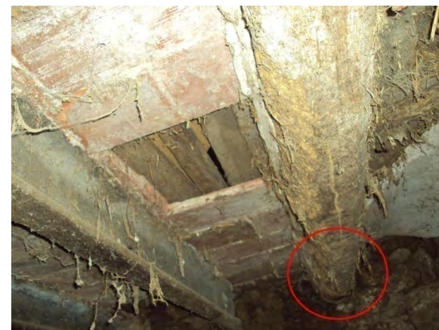
9.2.3/13. Cap d'una biga amb presència de humitats molt elevades
