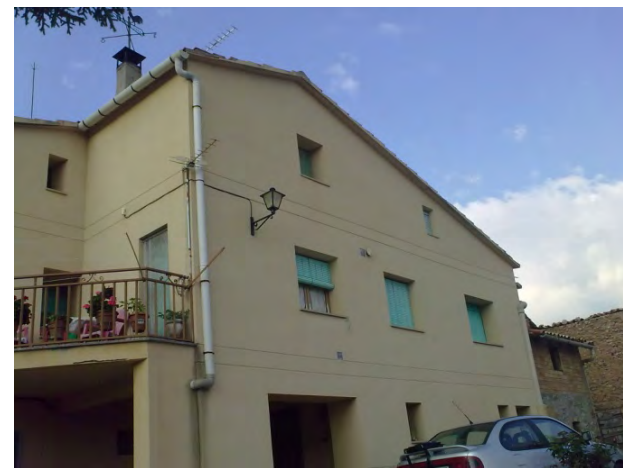
7.2.3/2. Façana Sud casa amb revestiment de morter de monocapa
