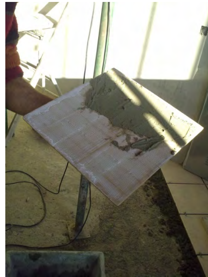
13.2.6/4. Imatge feta per l'autor, s'observa la llepada de morter cola d'adherència entre els dos materials.
