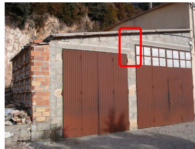
9.2.2/1. Façana Sud del Garatge, ubicació esquerra
