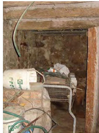
9.2.3/8. Apuntament d'urgència en una biga del corral "2"
