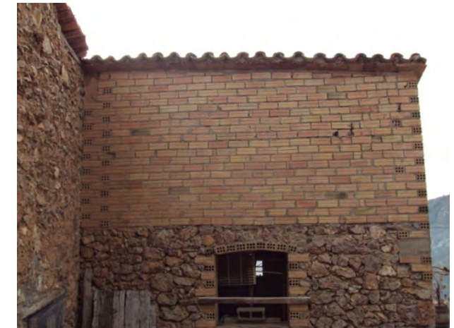
7.2.2.2/4. Es veu el canvi de material a 1,80 m del terra en el parament vertical del corral 4
