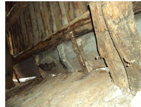
9.3/22. Biga 54 s'observa la taca en la part en contacte amb el desaigua
