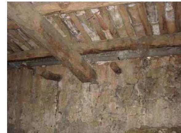
9.3/23. Cap dret de la jàssera J7 amb presència molt alta de humitat
