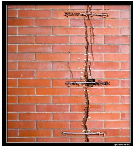
12/2. S'observa les grapes col·locades en un parament de fabrica que serveix d'exemple
