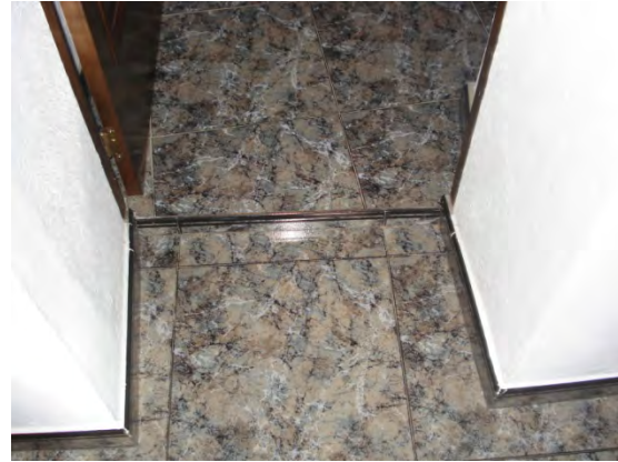
7.2.5/3. Planta segona de la casa, paviment ceràmic
