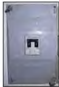
ICP precintat per la companyia
