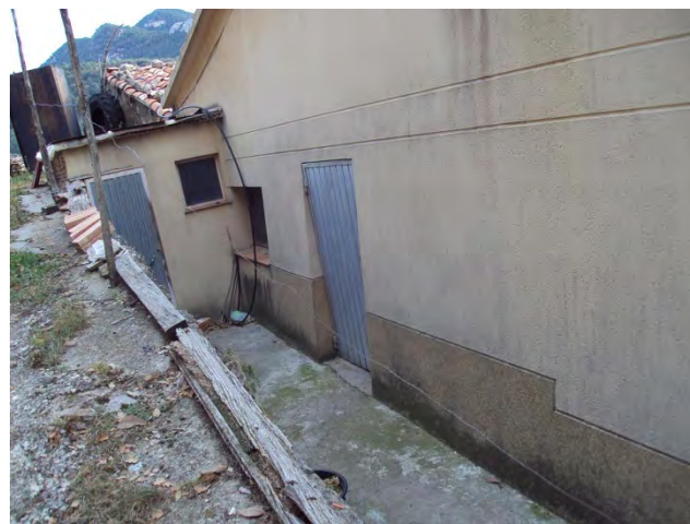
9.2.2/24. Paret Nord de la casa, s'observa en la part inferior les molses de color verd fosc
