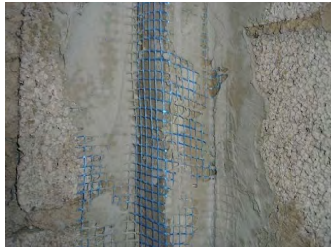
12/3. Sistema Mallatex encolat a la paret amb ciment cola
