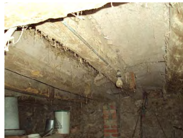
9.2.3/8. S'observa la fletxa en les bigues i l'apuntament realitzat
