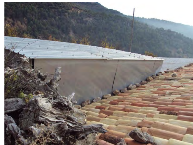
7.2.3/10. Coberta posterior de la casa amb planxes galvanitzades
