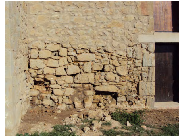
13.2.3.2/1. Imatge realitzada per l'autor sanejament de la paret de pedra per realitzar la consolidació posterior.
