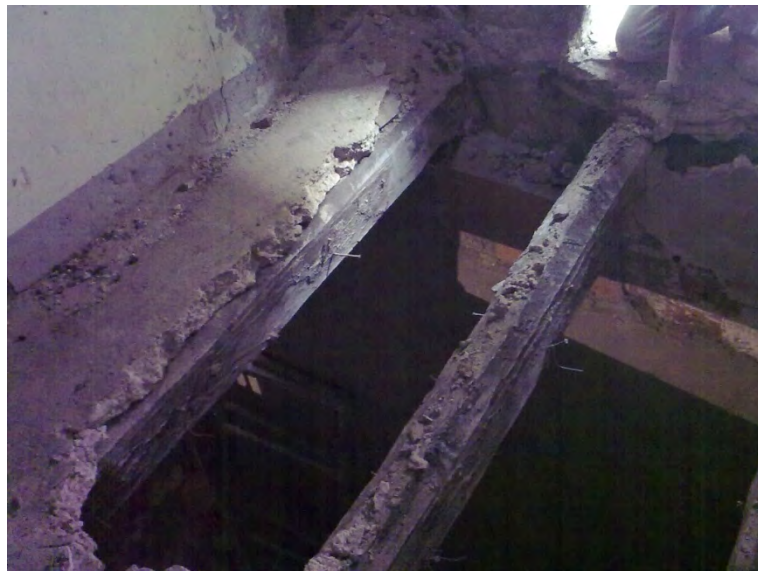
13.2.1/2. Imatge realitzada per l'autor del projecte, part extreta de l'entrebicat de les bigues deixant els elements resistents sanejats per una conseqüent col·locació del connectors.
