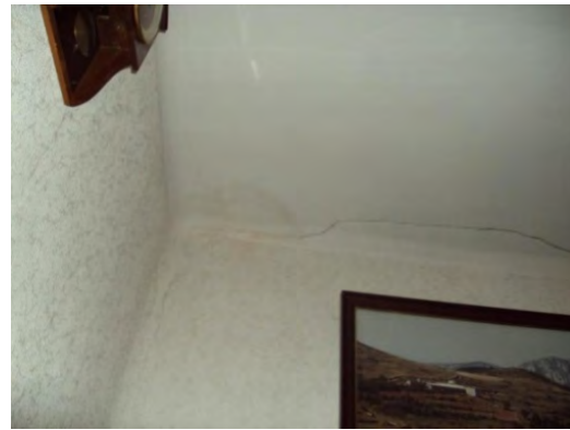
9.2.3/1. S'aprecia la part esquerra de l'esquerda en el menjador
