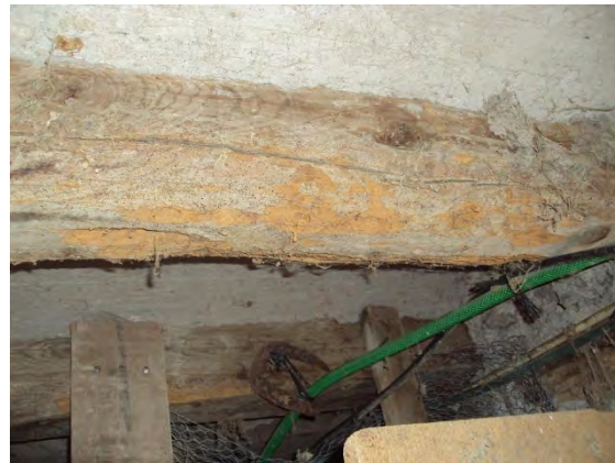
9.2.3/20. Corral "2" exemple de biga amb atac d'insectes
