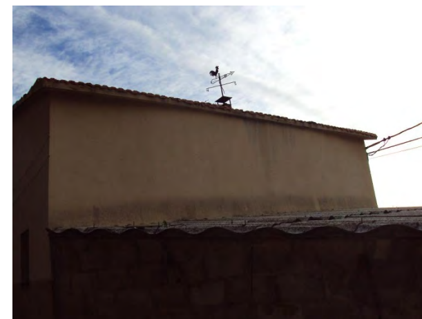
9.3/18. Taca lineal de presència de humita en el parament
