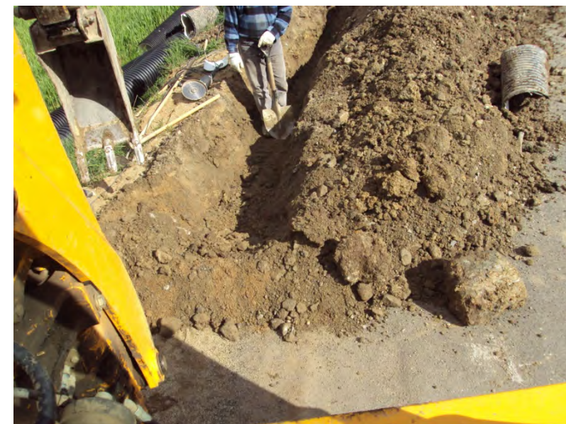
13.2.1/1. Imatge realitzada per l'autor del projecte, s'observa l'excavació d'una rasa amb mitjans mecànics.
