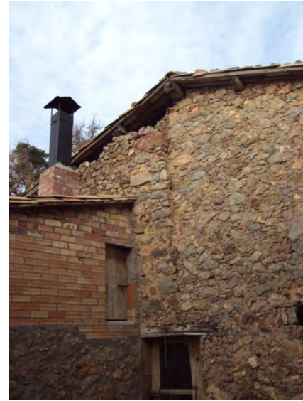
7.2.2.2/2. S'observa l'estructura vertical de la pallera
