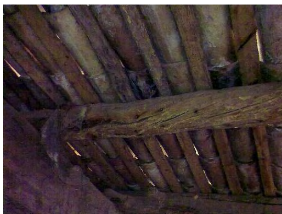
9.3/20. Humitat altes al cap esquerre i clivelles en el sentit de les fibres
