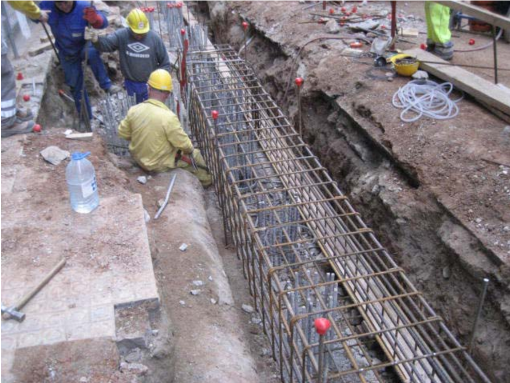
Figura 3.12. Ejecución de ferrallado vigas de atado.
