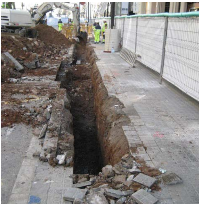
Figura 3.8. Excavación previa a ejecución pilotes
