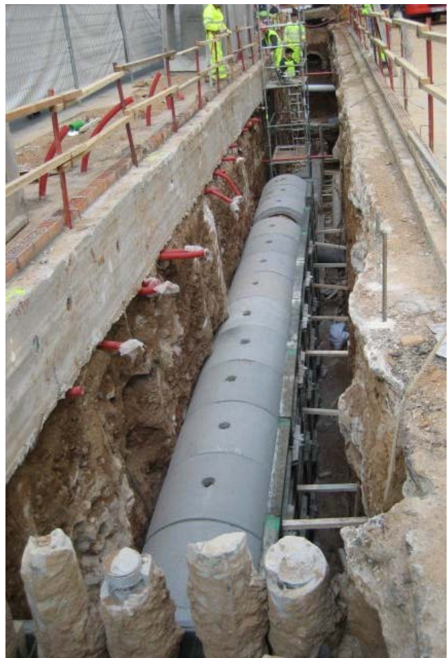
Figura 3.14. Colocación T-130 prefabricados
