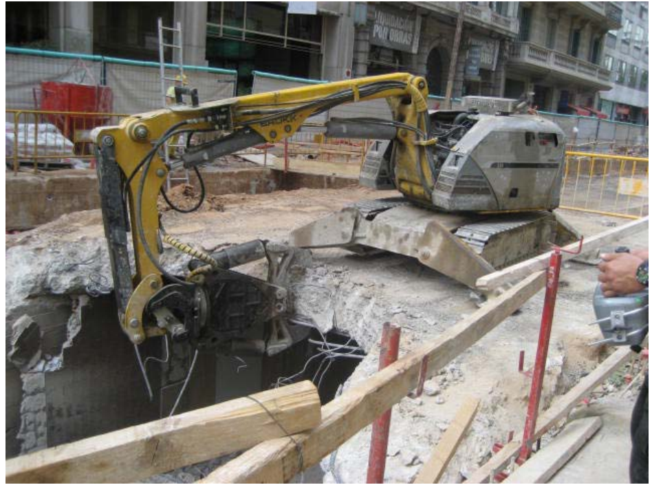
Figura 3.15. Demolición cajón existente con cabezal demoledor
