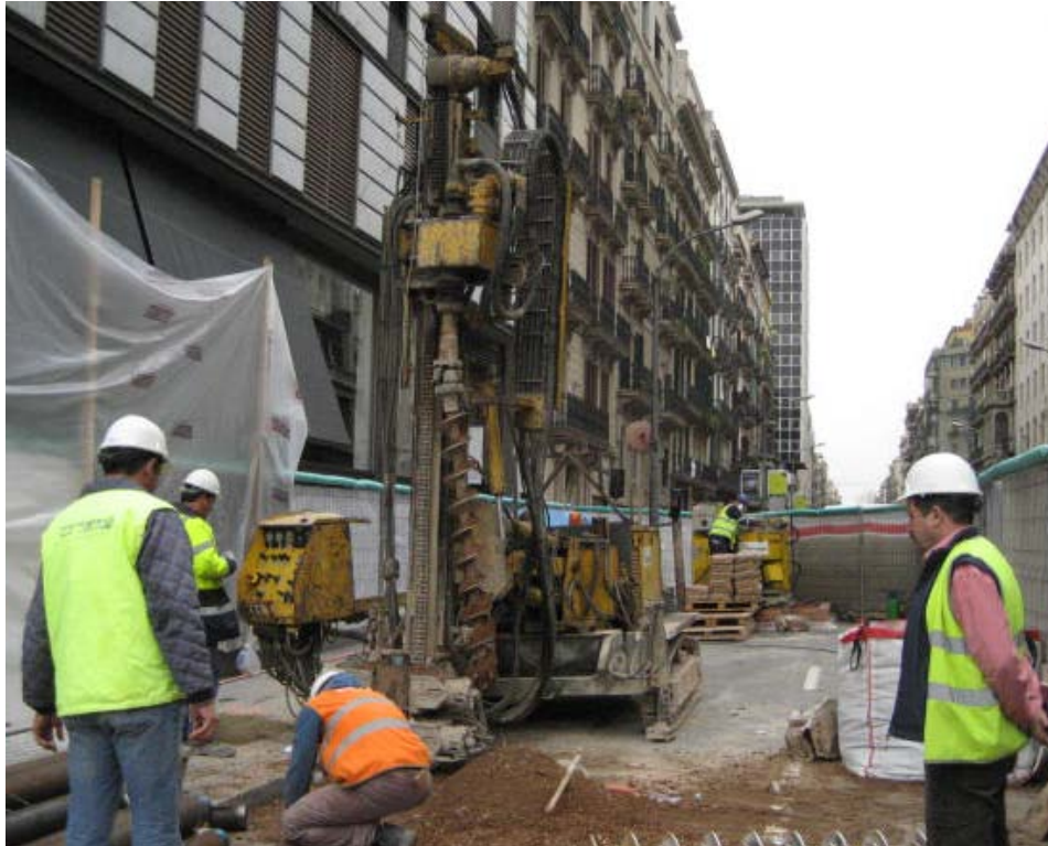
Figura 3.9. Ejecución pilotes de 45 cm y 1 m.
