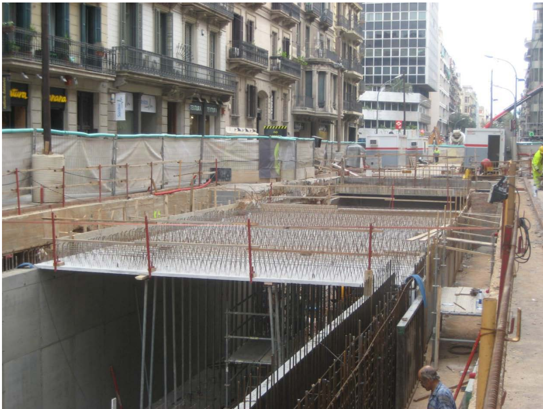
Figura 3.19. Ejecución cubierta con pre-losas pretensadas Atefor
