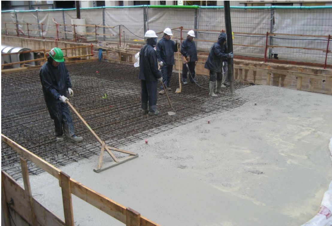
Figura 3.20. Ejecución hormigonado de cubierta.
