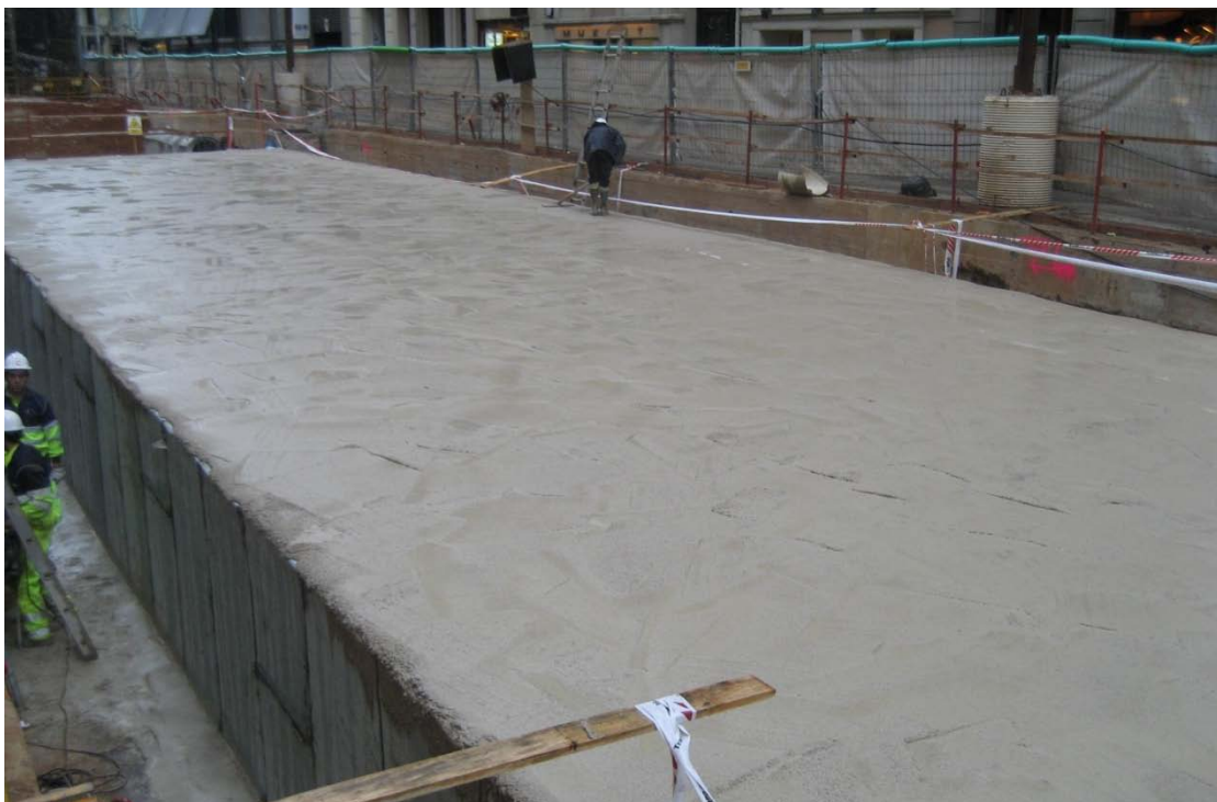
Figura 3.21. Ejecución impermeabilización cubierta.
