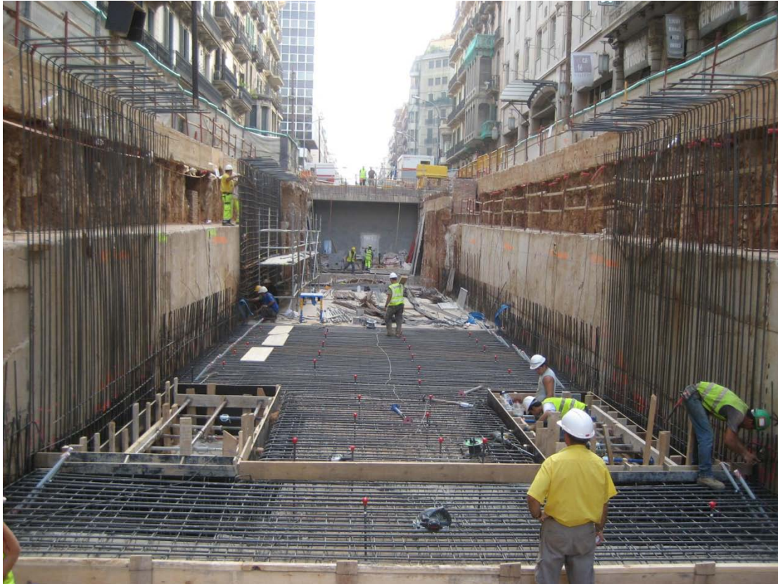
Figura 3.17. Vista ferrallado solera y hastiales cajón nuevo.
