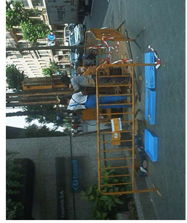
Màquina de sondeig Rolatec RL-48L
