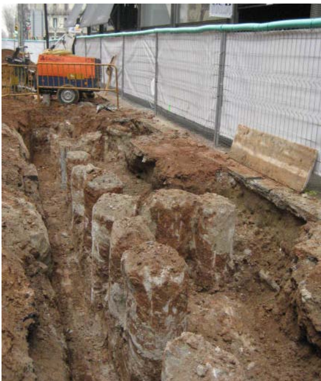
Figura 3.10. Limpieza del contorno de la cabeza de pilotes.
