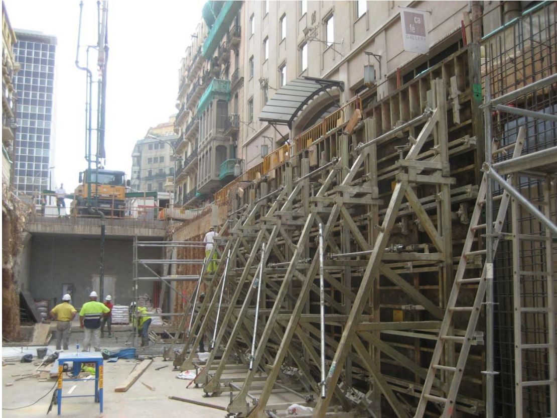
Figura 3.18. Vista encofrados hastiales cajón nuevo.
