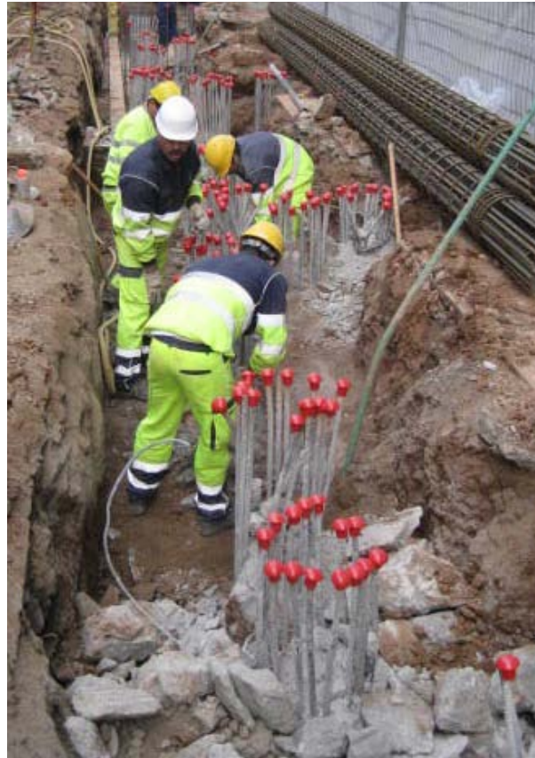
Figura 3.11. Demolición de hormigón en cabeza para solape.
