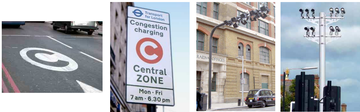
Figura 2. 4 Elements constituents del peatge d'entrada i circulació per Londres, d'esquerra a dreta: senyalització horitzontal i vertical, sistema de cobrament electrònic i sistema de vigilància
