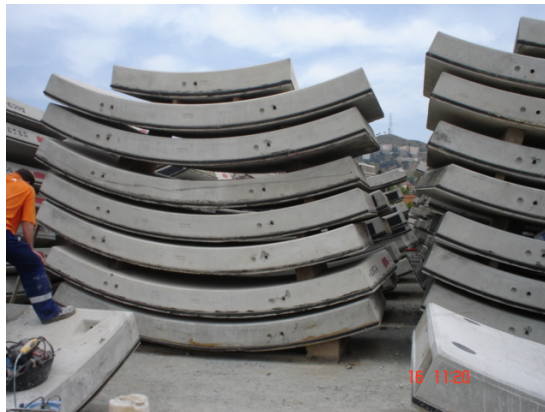
Fig. 4.5 Esquema d'apilament de les dovelles, L9 Barcelona
