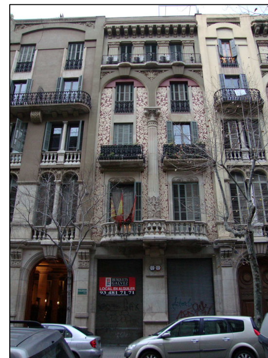
Figura 32 - Façana sense fulles ni sol
