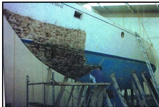
Figura 49: Fase del decapado. Fuente: autor
