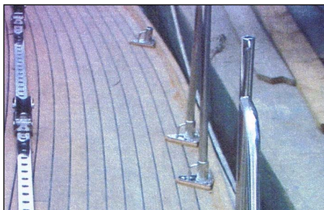
Figura 118: Carril y anclajes de cubierta instalados. Fuente: autor
