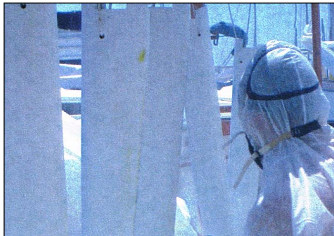
Figura 102: Última capa de pintura a las crucetas. Fuente: autor
