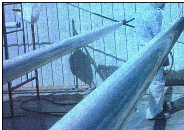
Figura 94: Imprimación y pintado. Fuente: autor
