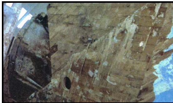
Figura 48: Desguace del forro. Fuente: autor
