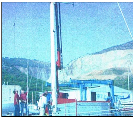
Figura 8: Ejecutando la maniobra en Port Ginesta
