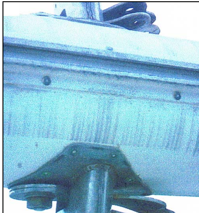
Figura 17: Arraigo inoxidable de las crucetas. Fuente: autor.
