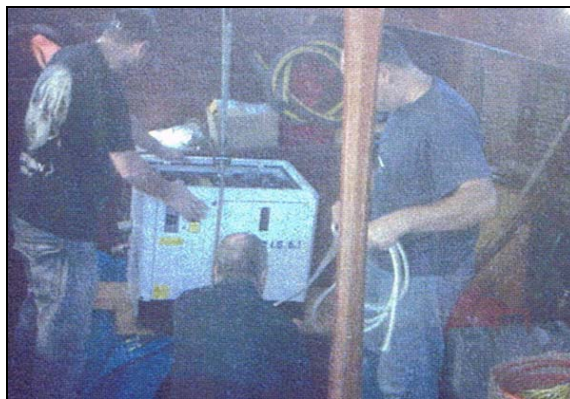
Figura 117: Instalación del generador. Fuente: autor
