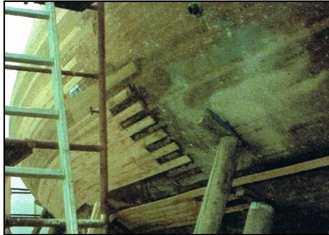
Figura 76: Acabado de la reparación del casco. Fuente: autor
