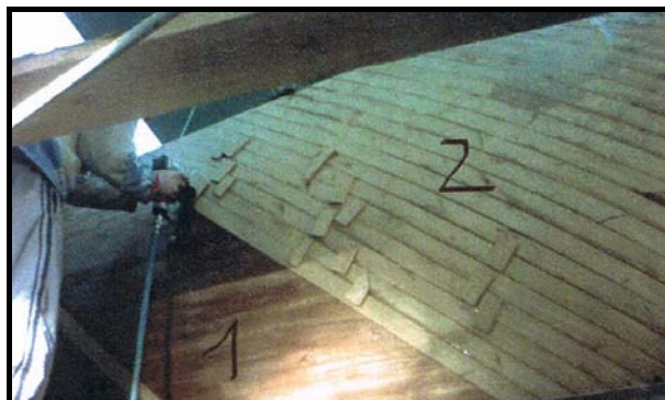
Figura 62: Laminado del primer y segundo forro. Fuente: autor
