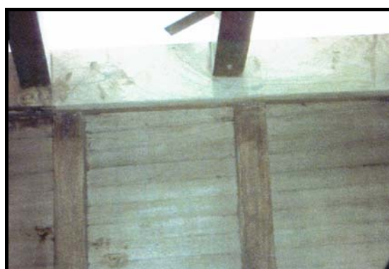
Figura 63: Durmiente, baos, forro y cuadernas. Fuente: autor
