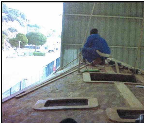
Figura 57: Inicio de restauración en la cubierta. Fuente: autor
