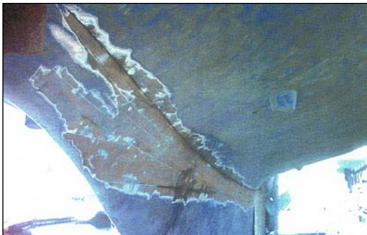
Figura 134: Pelado del taco de quilla. Fuente: autor
