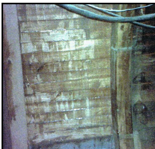
Figura 61: Saturado del laminado. Fuente: autor
