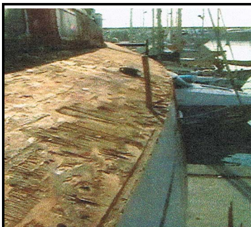
Figura 35: Saneado de la cubierta. Fuente: autor
