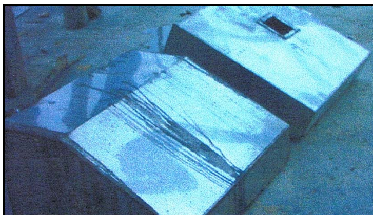
Figura 37: Tanques de gasoil. Fuente: autor
