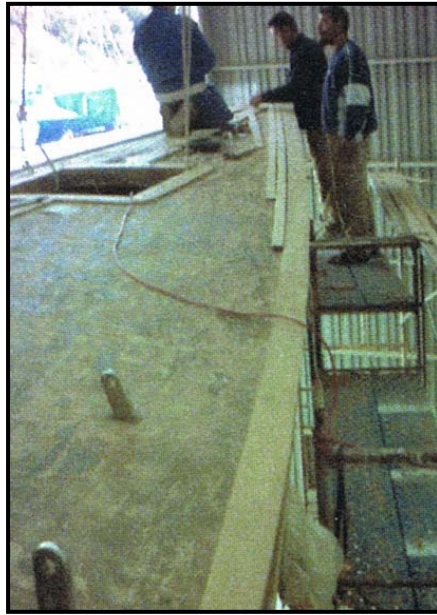
Figura 58: Montaje de las primeras tablas. Fuente: autor
