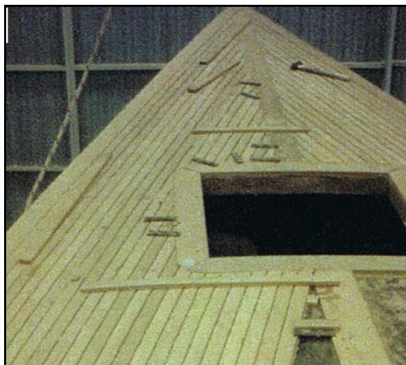
Figura 82: Terminando el cubrimiento de teca. Fuente: autor
