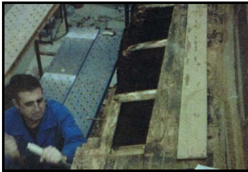
Figura 47: Durmiente, baos y cubierta. Fuente: autor
