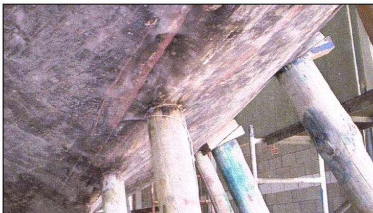
Figura 96: Masillado de las juntas abiertas. Fuente: autor
