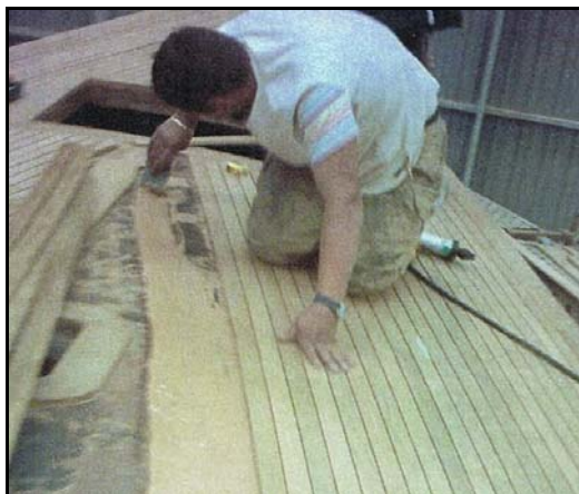
Figura 85: Aplicación del sellante. Fuente: autor
