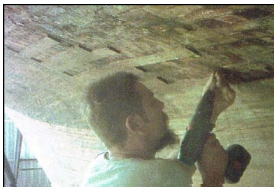
Figura 93: Tirafondos del casco a las cuadernas. Fuente: autor
