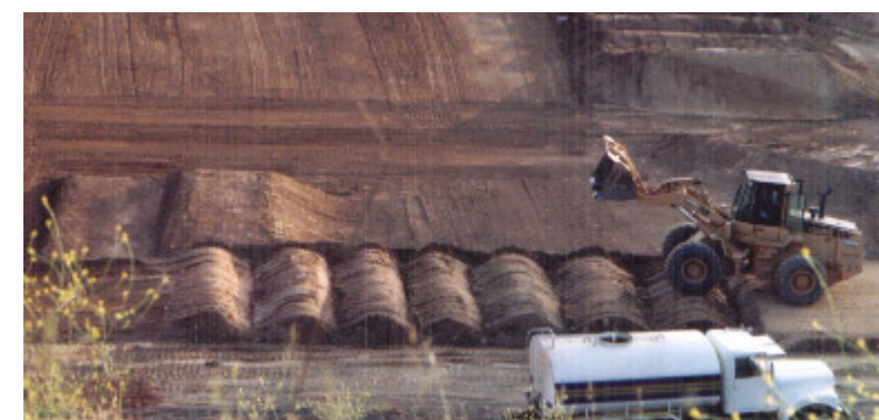
fig.3.2.4 –Imagen de maquinaria pesada trabajado en la construcción de un circuito.
