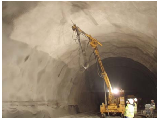
Figura 2.7 - Máquina proyectando en un túnel.
