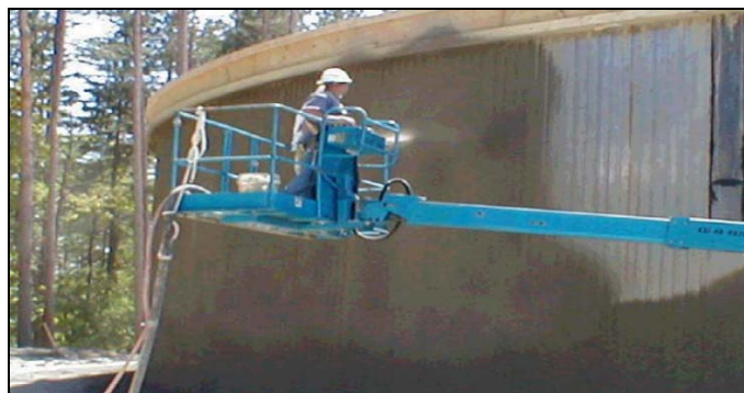
Figura 2.9 - Operario proyectando sobre un depósito.
