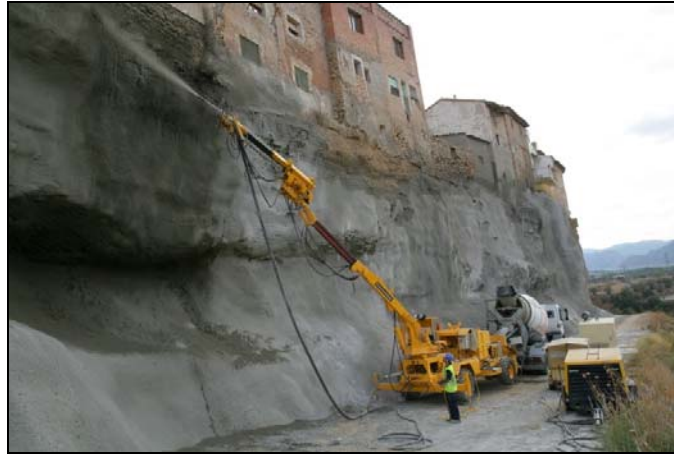
Figura 2.8 - Estabilización de taludes.
