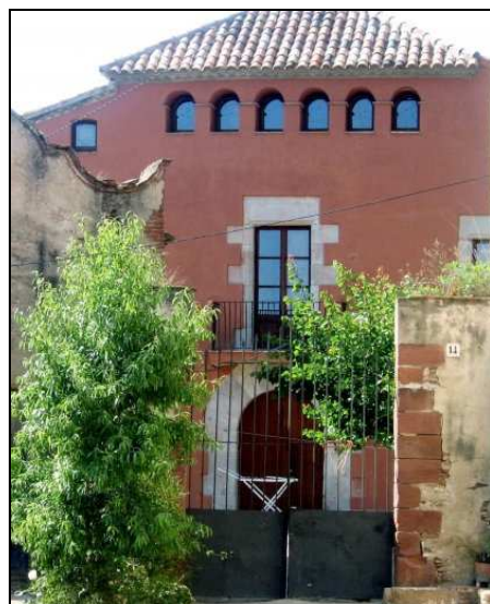
Fig. 3.2 Accés principal al complex
