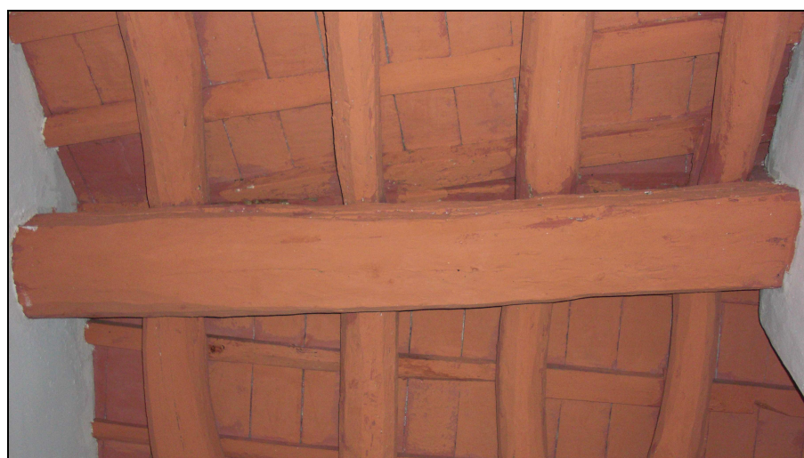
Fig. 3.24. Imatge interior del forjat de la Planta Pis
