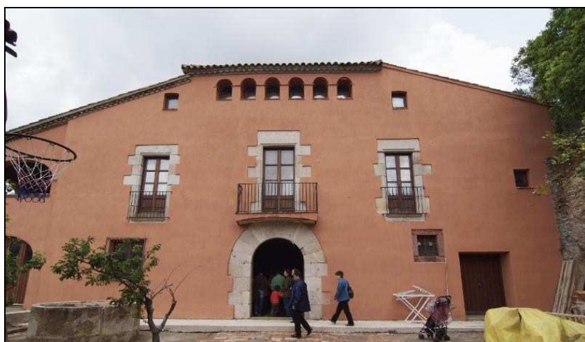
Fig.3.3. Façana principal de la masia de Can Molins
