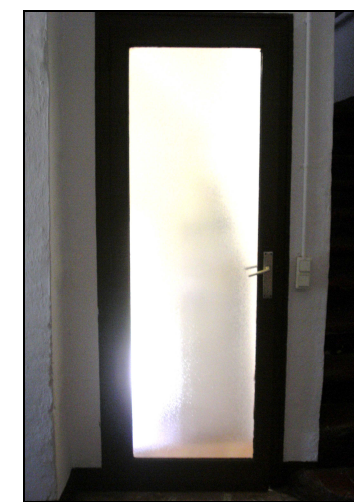
Fig.3.31. Porta interior existent entre menjador i cuina
