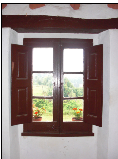
Fig. 3.28. Finestra doble fulla tipus
