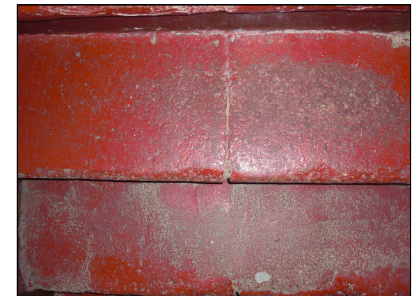
Fig.4.6.Desgast del paviment de les escales
