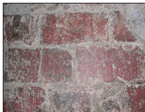
Fig. 3.27. Paviment maó ceràmic massís del safareig
