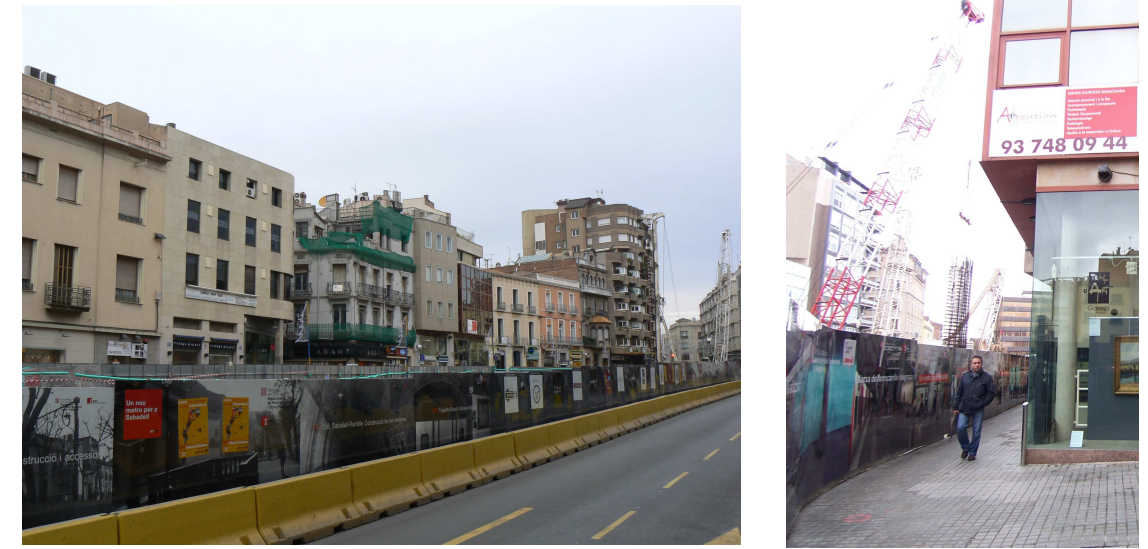
A la esquerra s'aprecia la longitud del ballat. A la dreta l'espai del que es disposava.
