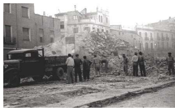
Enderroc de les primeres cases del Carrer Pedregar.
