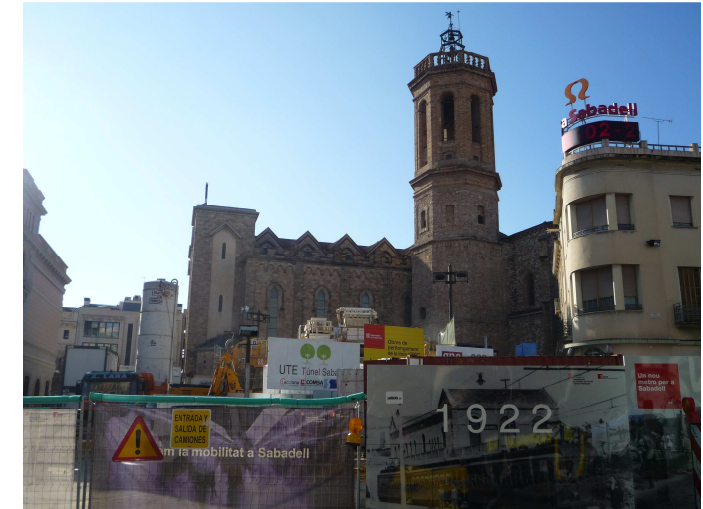
2010. Actualment està en obres.
