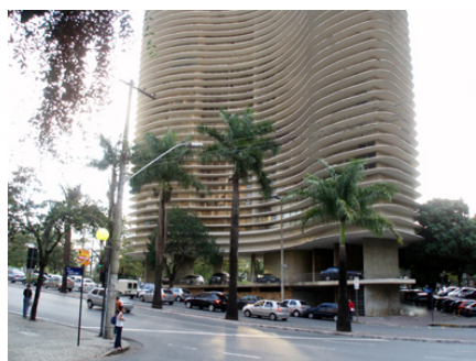
19. Vista del edificio con la Plaza al fondo.
