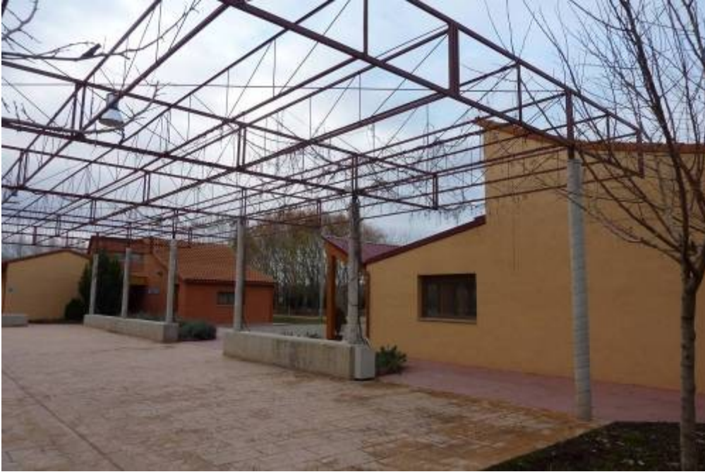
Imagen 7.3.- Detalle marquesina para instalación fotovoltaica..“Les Obagues”. Fuente: Elaboración propia.
