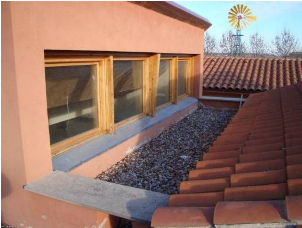
Imagen 6.4.- Vista de la cubierta edificio habitaciones para instalación ACS..“Les Obagues”. Fuente: Elaboración propia.
