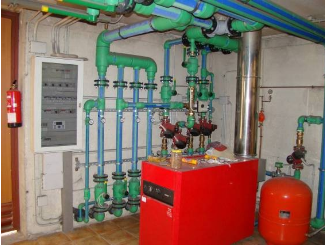
Imagen 4.3.- Interior Torre energia.. “Les Obagues”. Fuente: Elaboración propia.
