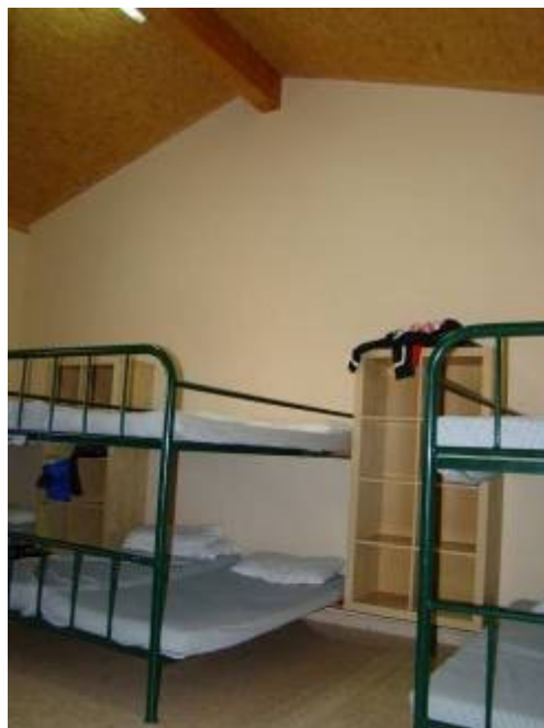
Imagen 5.6.- Detalles Techo habitación. "Les Obagues". Fuente: Elaboración propia.
