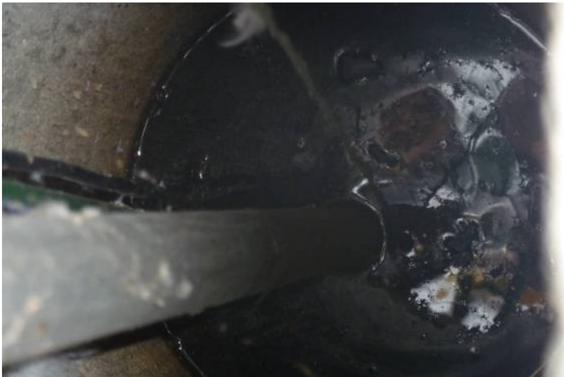
Imagen 3.4.- Detalle pozo bombeo. “Les Obagues”. Fuente: Elaboración propia.
