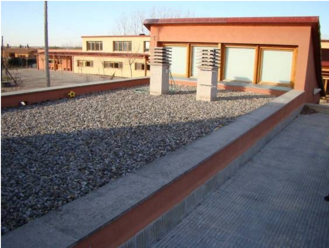
Imagen 6.5.- Vista de la cubierta edificio habitaciones para instalación ACS..“Les Obagues”.
