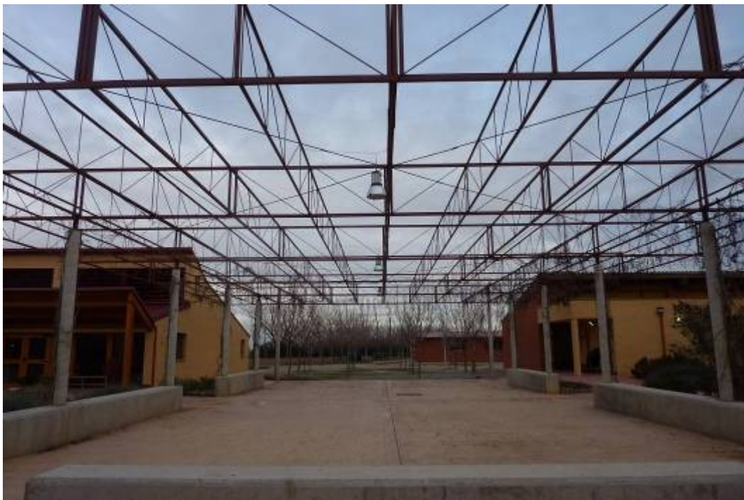
Imagen 7.2.- Detalle marquesina para instalación fotovoltaica..“Les Obagues”. Fuente: Elaboración propia.
