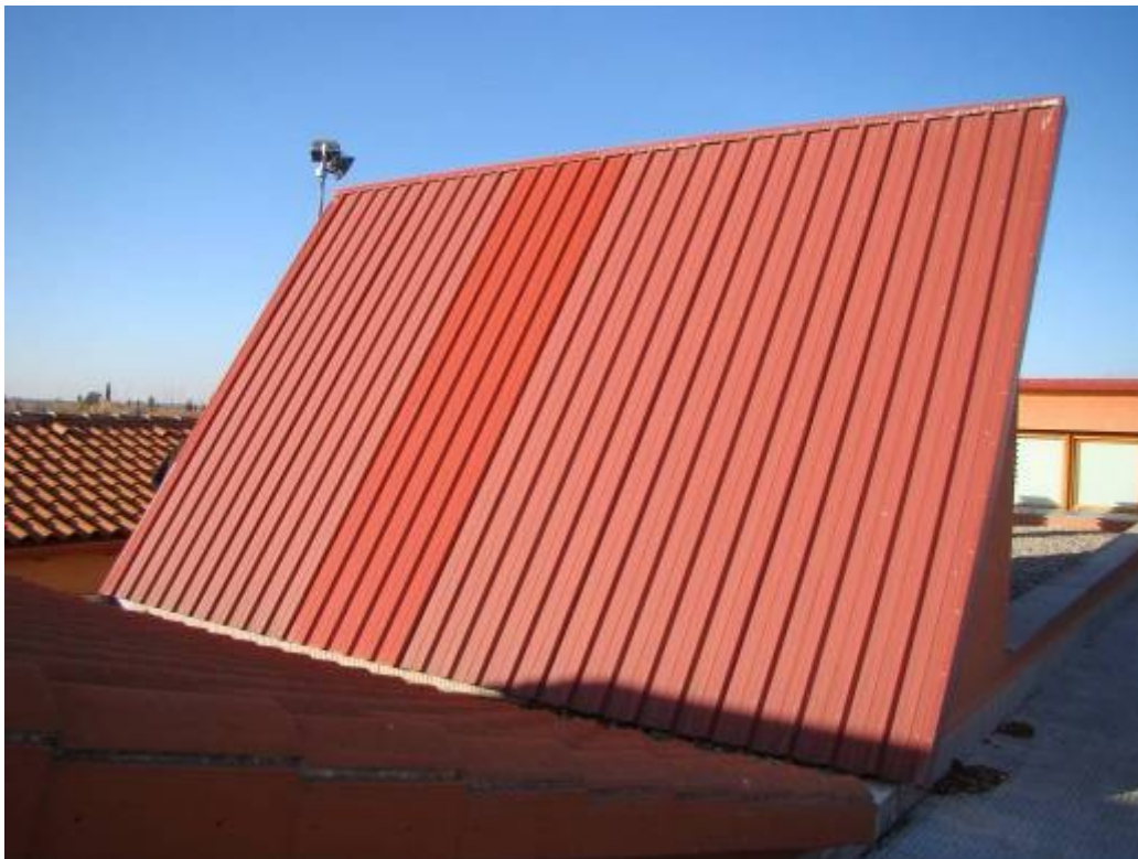
Imagen 6.2.- Vista de la cubierta edificio habitaciones para instalación ACS..“Les Obagues”. Fuente: Elaboración propia.
