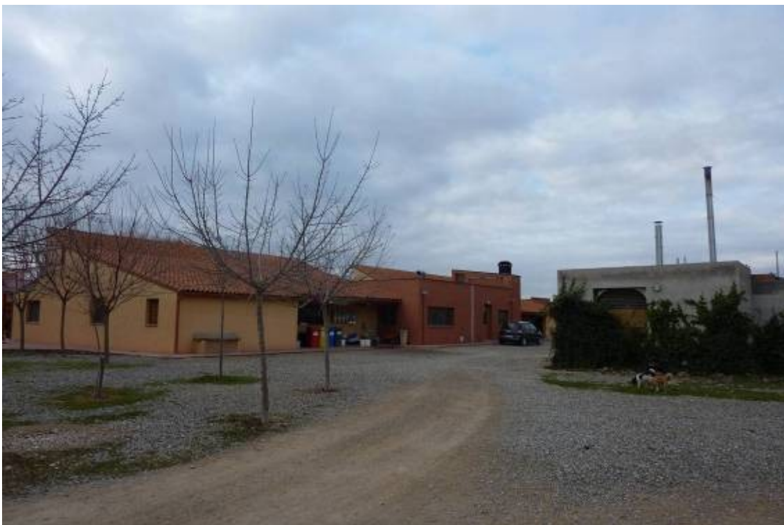
Imagen 2.2.- Vista posterior edificio comedor, cocina y talleres del centro “les Obagues”. Fuente: Elaboración propia.
