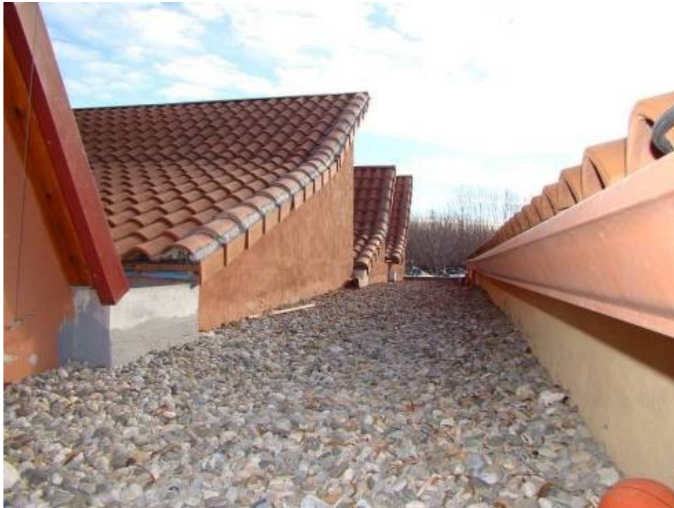
Imagen 6.3.- Vista de la cubierta edificio habitaciones para instalación ACS..“Les Obagues”. Fuente: Elaboración propia.
