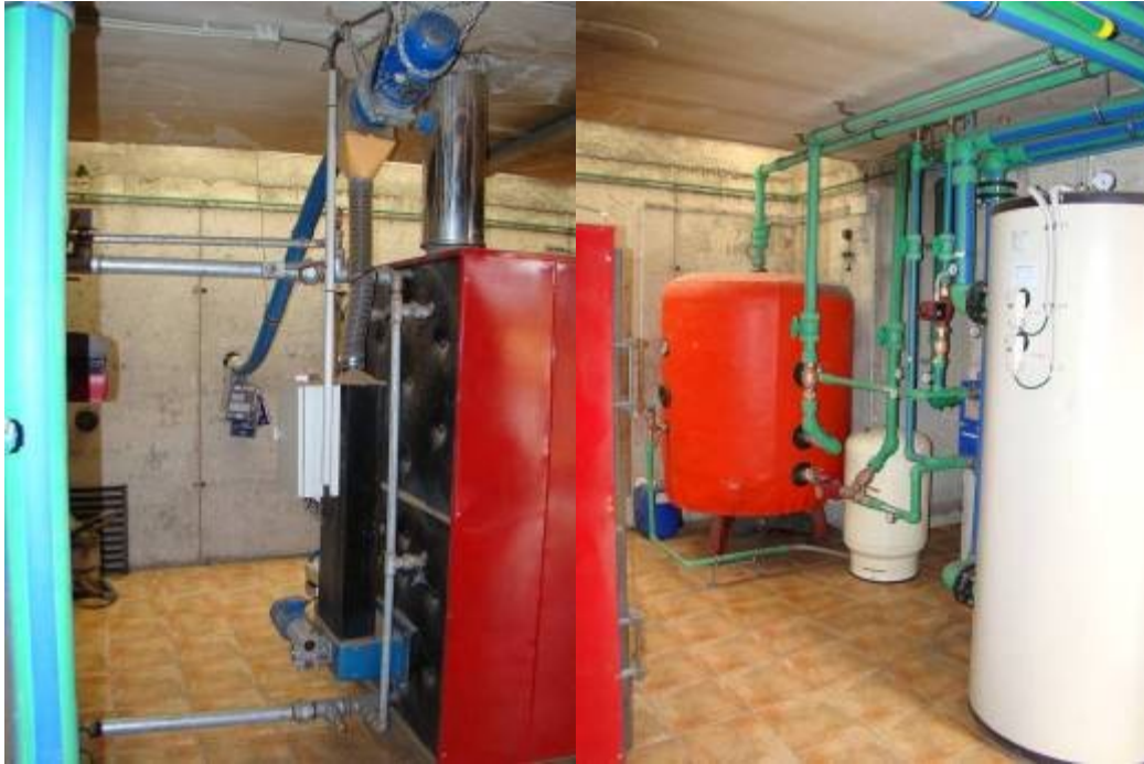
Imagen 4.5.- Interior Torre energia.. “Les Obagues”. Fuente: Elaboración propia.
