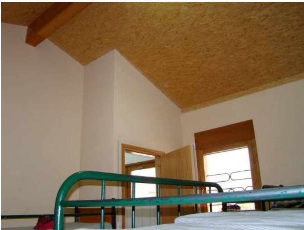
Imagen 5.5.- Detalles Techo habitación. "Les Obagues". Fuente: Elaboración propia.
