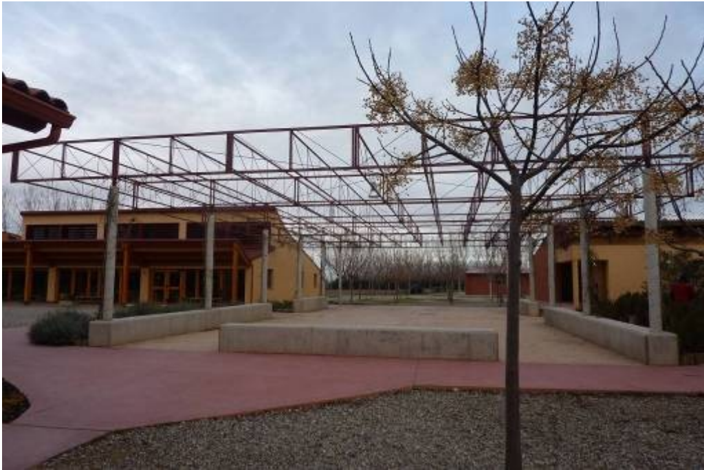
Imagen 7.1.- Detalle marquesina para instalación fotovoltaica..“Les Obagues”. Fuente: Elaboración propia.
