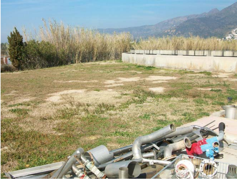
Foto 5: EDAR Roses: zona propera als decantadors.
