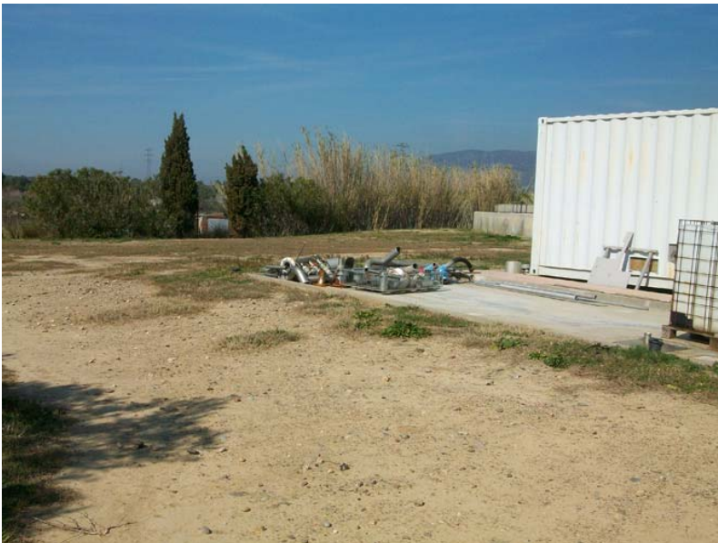
Foto 6: EDAR Roses: Espai on es construirà l'edifici definit en el present projecte.
