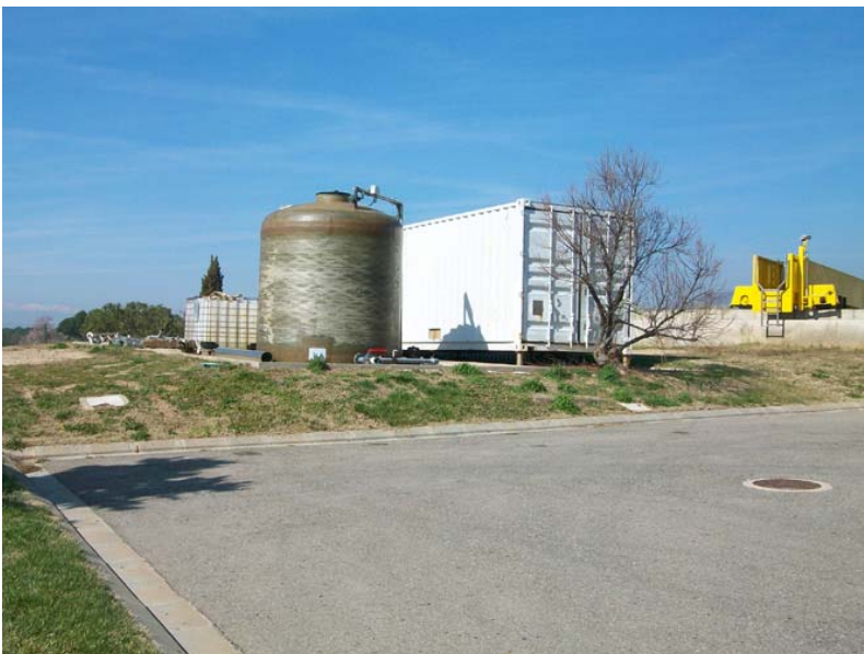
Foto 4: EDAR Roses: àrea d'accés a l'edifici del projecte.
