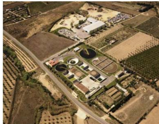
Fotografia 2: vista aèria EDAR Roses, amb tractament terciari ubicat dins un contenidor
