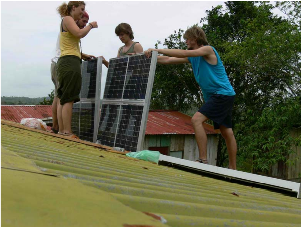
4. Primera parte de la instalación de los paneles solares en La Aurora.
