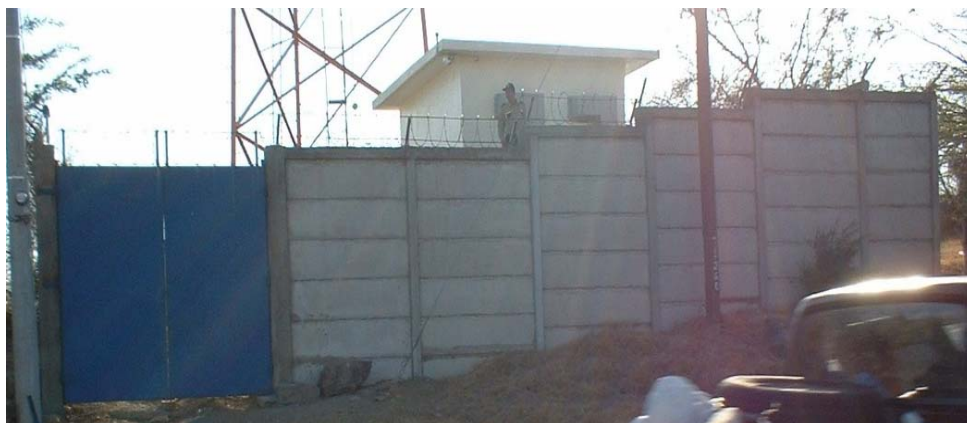
Estructura que resguarda la antenas (foto V. Ramírez P. Marzo del 2005)
