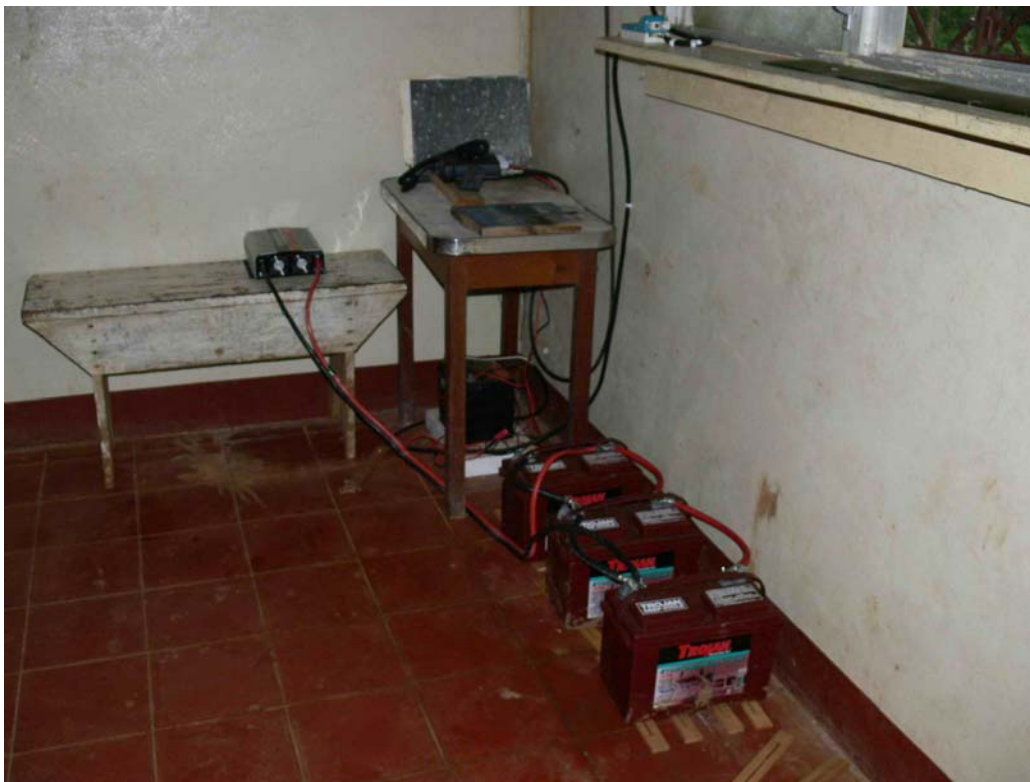
6. Primera parte de la instalación de los paneles solares en La Aurora.
