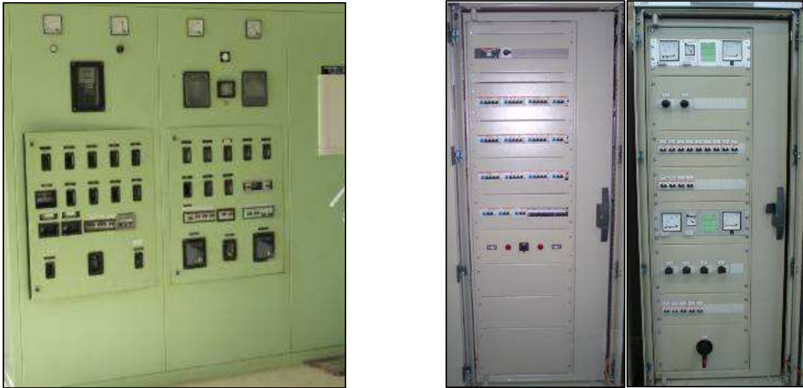
Fig 4.23 Evolución de los SSAA (armarios de CA y CC). Armarios antiguos y actuales, de izquierda a derecha respectivamente, elaboración propia
