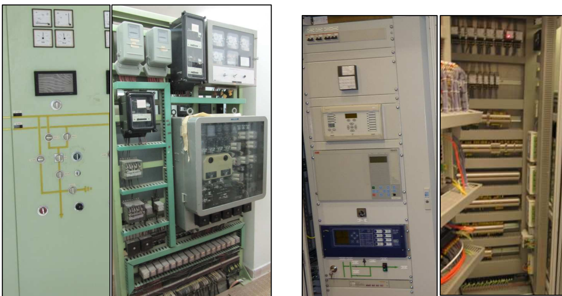
Fig 4.22 Evolución del sistema protector y de mando de una línea. Sistema antiguo y actual, de izquierda a derecha respectivamente, elaboración propia
