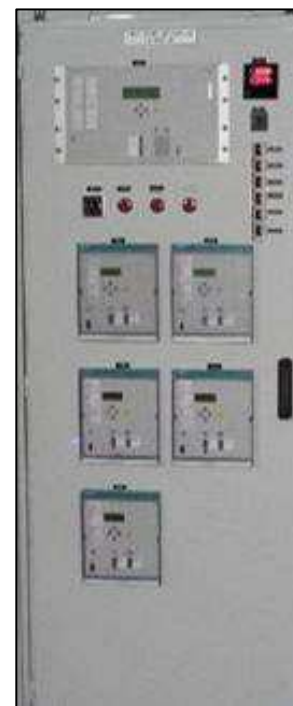
Fig 4.6 Prot. diferencial de barras distribuida, elaboración propia
