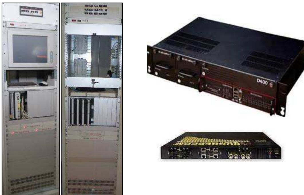
Fig 5.1 Evolución del sistema concentrador de información de la subestación y comunicación con el centro de control, a la izquierda el actual y a la derecha el que se instala en dicho proyecto, elaboración propia
