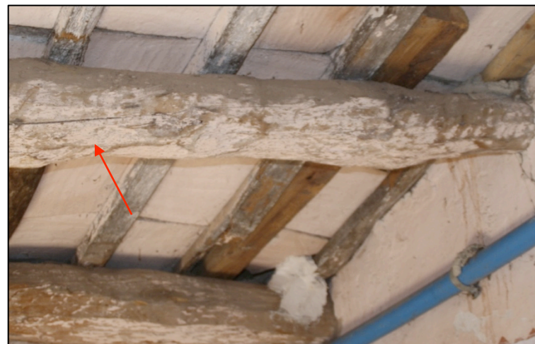
Foto 25: Clivella a la biga C2 a la part inferior d'aquesta.
