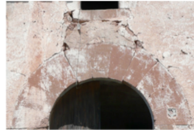
Foto 14: Arc de façana principal per l'exterior
