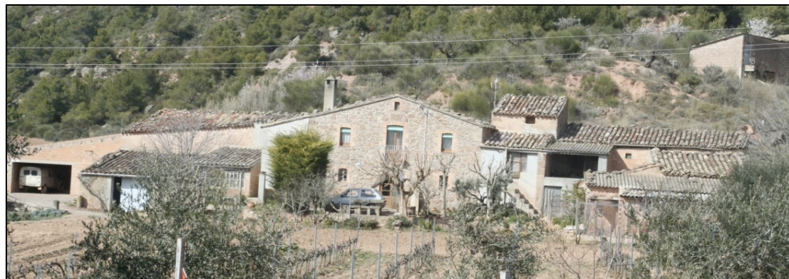
Foto 36: Masia de l'entorn amb els annexos de construccions posteriors
