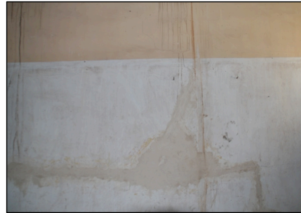
Foto 30: Esquerda per aixafament de morter
