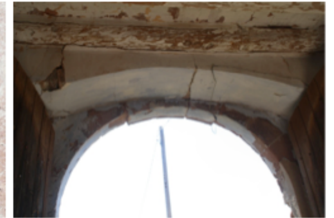
Foto 16: Arc façana principal per l'interior
