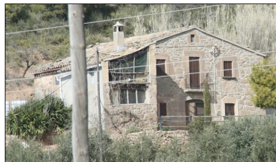
Foto 34: Façana principal de pedra vista
