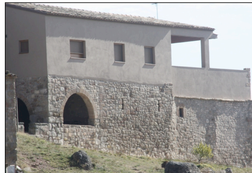
Foto 33: Façana masia de la zona on combina l'arrebossat amb la pedra
