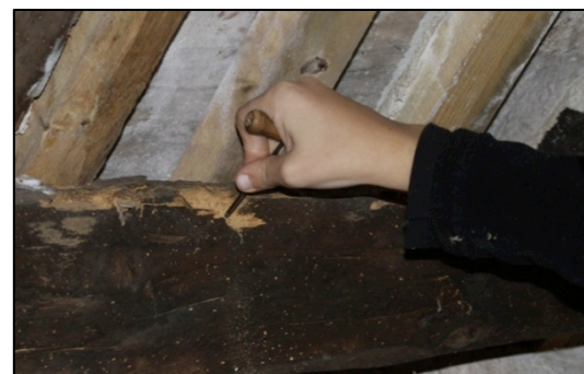
Foto 18: Utilització d'un punxó
