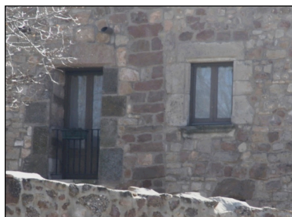
Foto 32: Balcons i finestres amb els carreus perimetrals i façana de pedra vista
