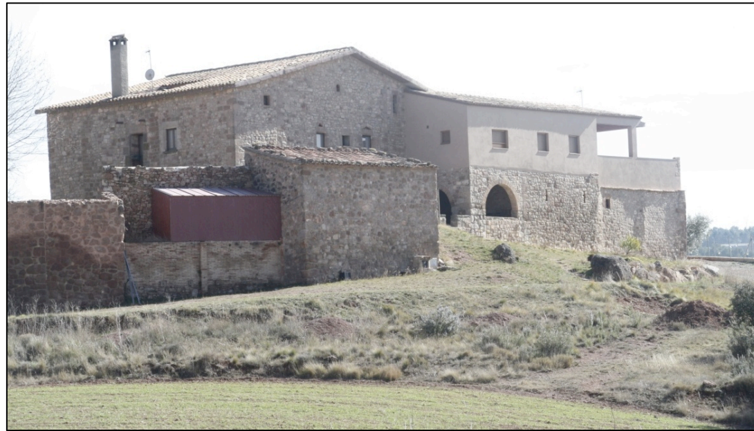
Foto 35: Masia de l'entorn amb els annexos de construccions posteriors
