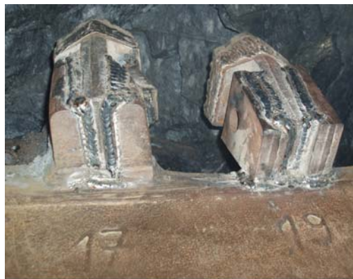
Figura 7.13 Detalle de la solución provisional picas 17 y 19: Soldadura directa de la pica sobre el portapicas.
