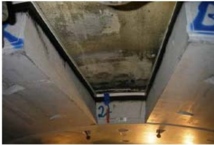
Figura 4.6 Espacio libre antes de la colocación dovela de cierre.
