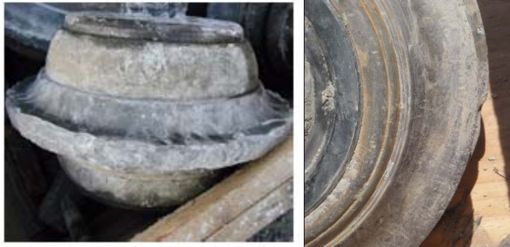
Figura 7.7 Detalle rotura de fragmentos del anillo de corte “chipping”.
