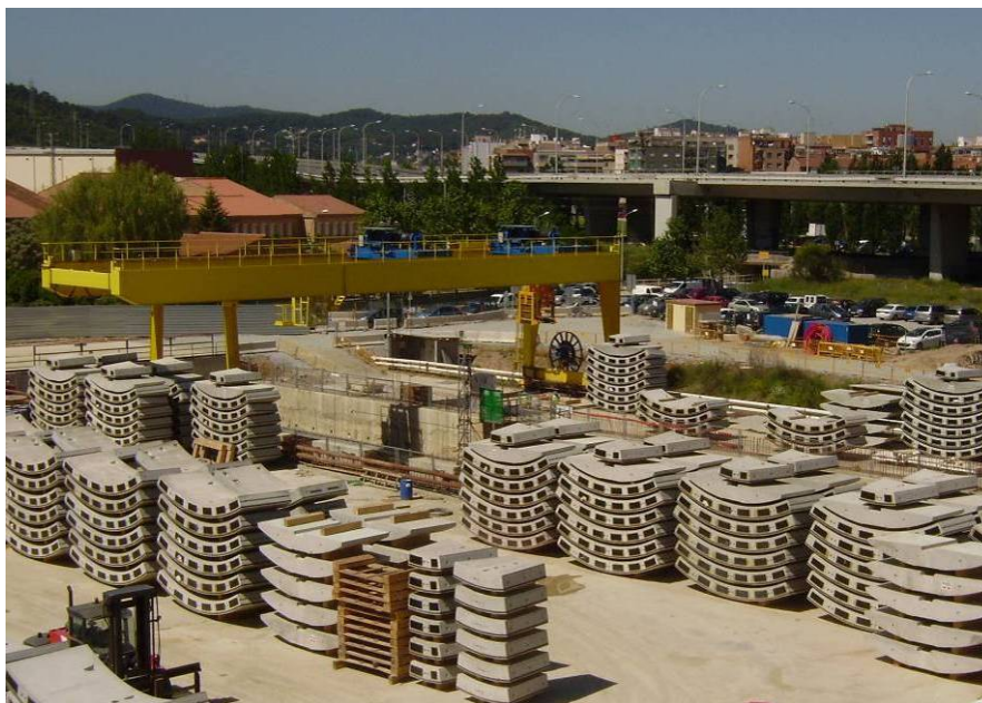
Figura 4.3 Vista de zona de acopio y descarga. Moncada y Reixac 2009
