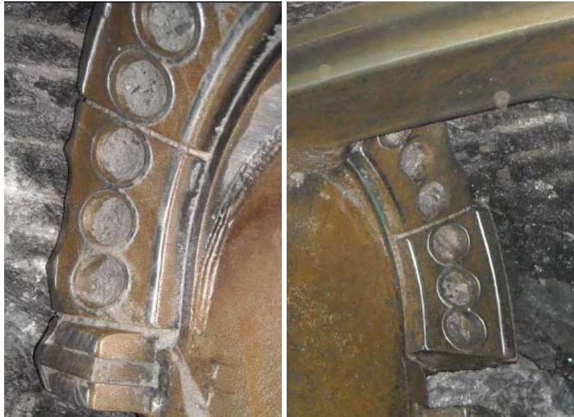
Figura 7.14 Detalle de desgaste (ondulación) de un rastrel posición interior izquierda (imagen izquierda) y de un rastrel posición exterior derecha (imagen derecha).
