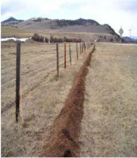
Instal·lació d'una berma filtrant de compost i resultat després de set mesos.
