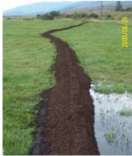
Instal·lació d'una berma filtrant de compost i resultat després de set mesos.
