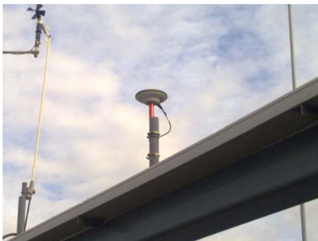
Figura 6-4. Estación de referencia GPS.
