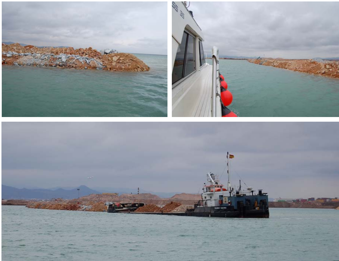
Figura 6-2. Imágenes tomadas desde la embarcación durante la realización del levantamiento. En las dos primeras se observa el estado de la mota de tierra y en la tercera hay un gánguil posándose justo en frente de la mota preparado para descargar las tierras.
