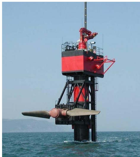
Seaflow instal·lat a les costes del Regne Unit, amb el rotor fora l'aigua, fet que en facilita l'accés.
