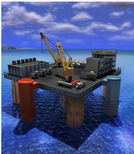
Disseny CAD renderitzat de la planta maremotèrmica de 10 MW de l'empresa Lockheed Martin's Alternative Energy Development (EUA).
