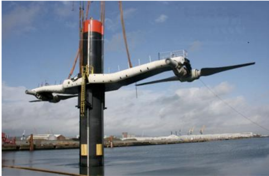
Seagen amb els rotors fora l'aigua per operacions de manteniment.
