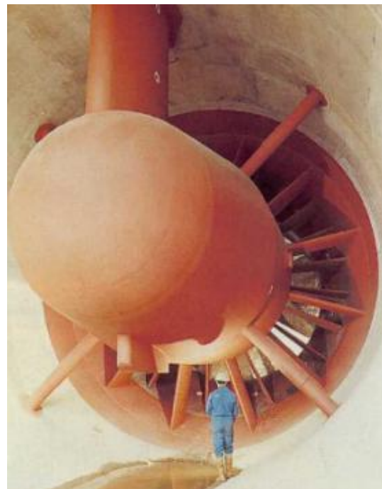
Turbina Kaplan reversible de 10 MW situada a l'interior d'un conducte. En procés de manteniment.
