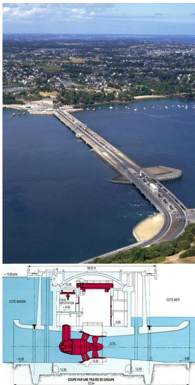
Imatge de la presa de la Rance (superior) I esquema del sistema de generació elèctrica (inferior).
