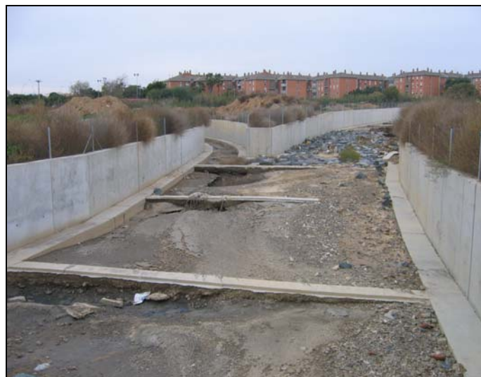
Fig. 66 Vista desde aguas abajo de la confluencia de dos torrentes. Tras la confluencia el lecho está estabilizado con traviesas de hormigón mientras que en la incorporación del torrente de la derecha de la imagen hay una zona protegida por escollera. Fotografía tomada por Bateman (Reus, 2006) .
