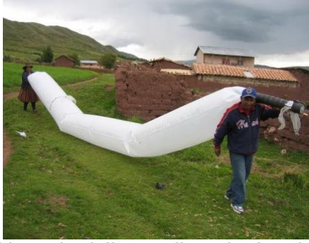
Llevando el digestor lleno de aire a la fosa
