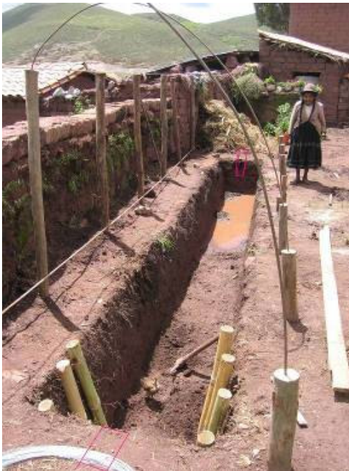
Fosa acabada de excavar. Todavía faltan los espacios por donde pasarán los tubos de carga y descarga (en la foto pintados en rojo).
