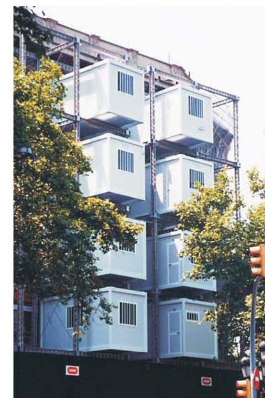
Casetas de Obra dentro de la Estructura del Soldier
