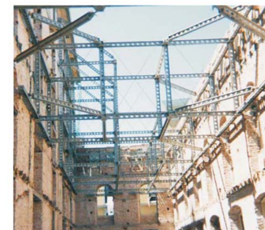
Estabilizador Interior amarrar a dos fachadas
