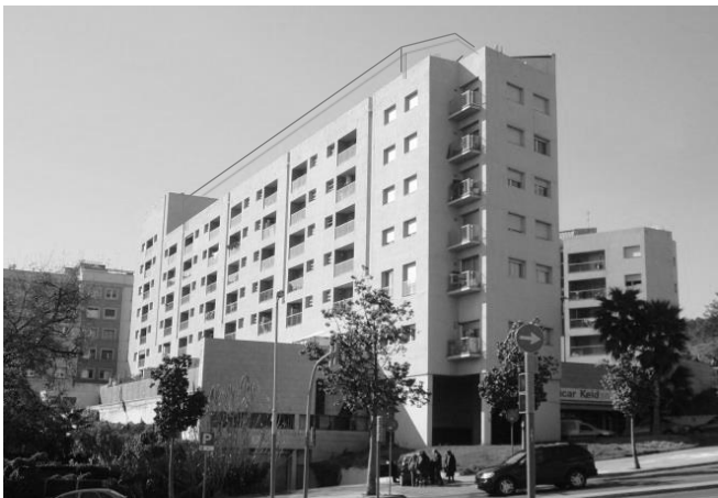
Imatge 2.1 Vista general de l'edifici de referència
