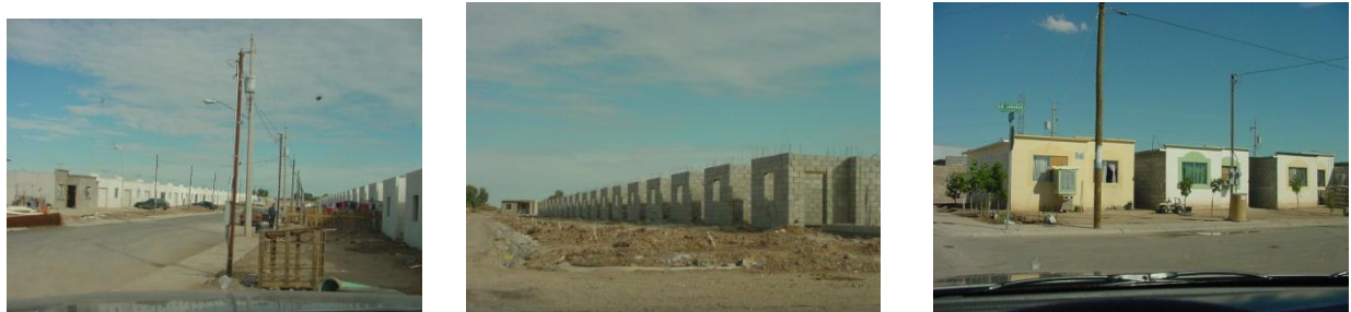
Figura 5. Vivienda de Interés Social en la ciudad de Mexicali, B.C.
