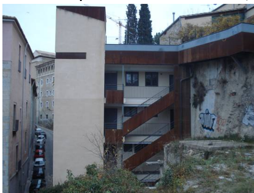
Figura 5. Ascensor público en edificio residencial, Girona
