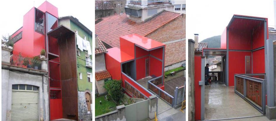
Figura 6. Ascensor de mejora de acceso entre barrios, Ripoll
