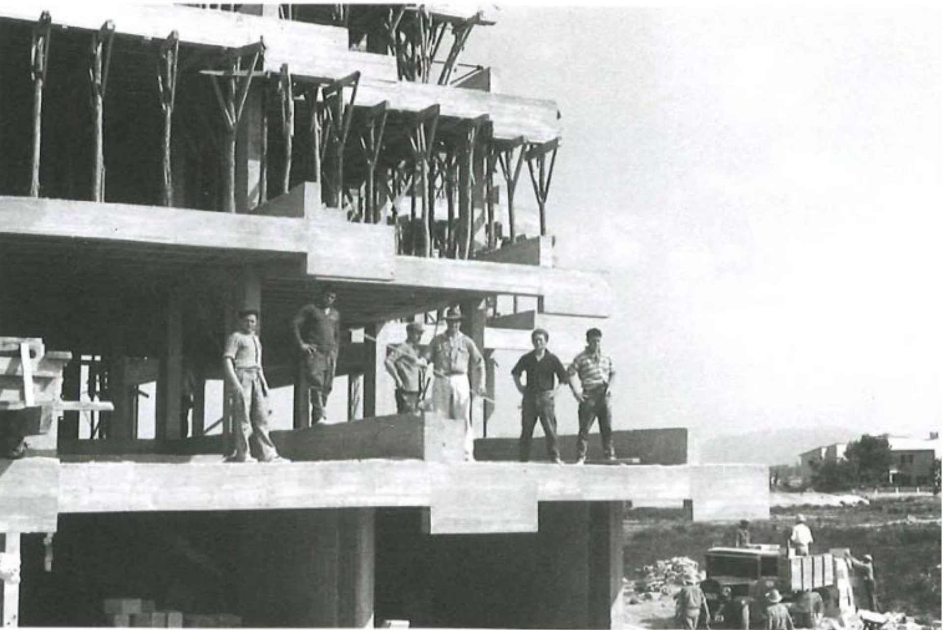
Sáenz de Oíza, F.J. Ciudad Blanca in Alcudia, 1961. In construction
