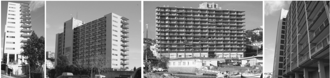
Edifici Jaume I, Sant Feliu de Guíxols (Girona) Elaboració pròpia
