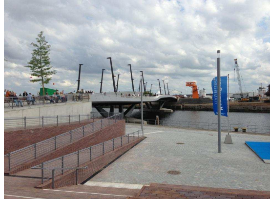
Imagen 27 - Puente Baakenhafenbrücke. Se muestra la continuidad peatonal debajo del mismo y las rampas que lo vinculan a la cota de calle.
