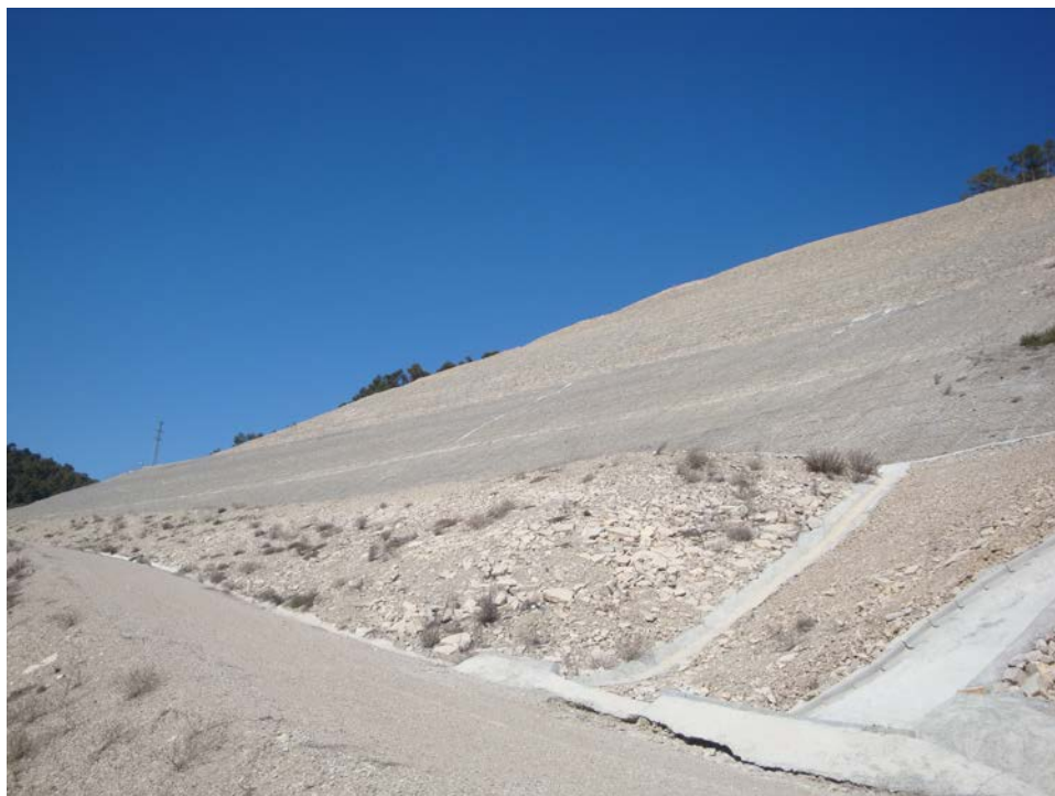
Fotografia 3. Obres de restauració de l'eslavissada sobre l'Autopista A - 2
