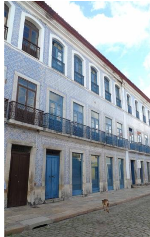
Figura 7: Edifício da Rua Portugal, São Luís Fonte: Leite (2012)
