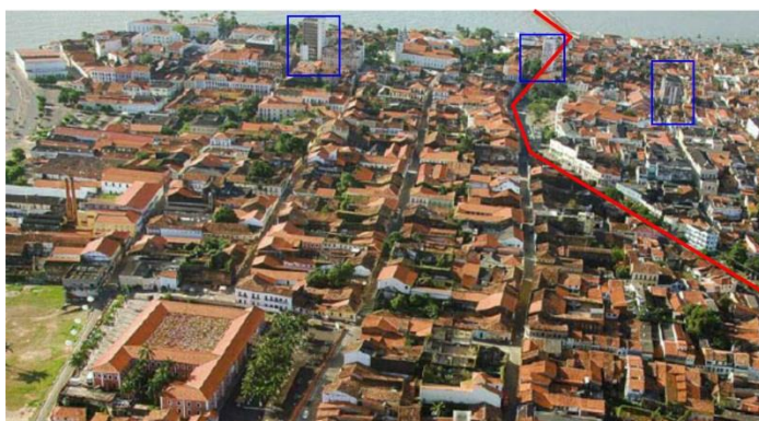
Figura 3: Vista do Centro Histórico de São Luís. Demarcação da abertura do eixo a vermelho e edifícios verticais a azul (autora). Fonte: Lopes, 2006: 20
