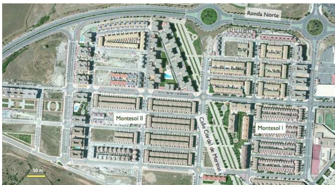
Figura 6 - Calle-plaza Cordel de Merinas
