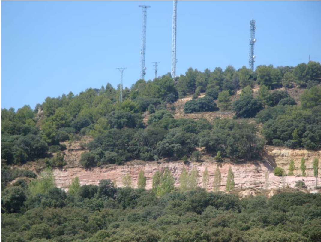
Antiguas explotaciones de caolín en la Muela Alta (la Venta de la Pintada , Gargallo)
