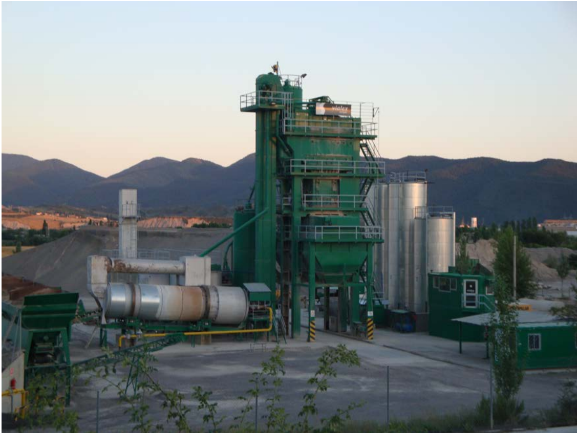
Planta de tratamiento de áridos
