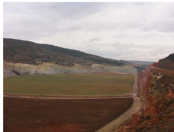
Aspecto de la corta restaurada
