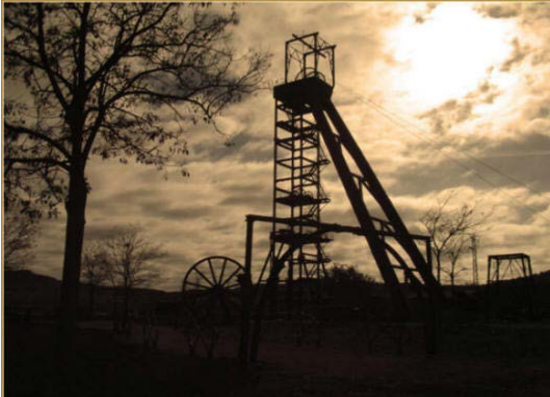
Fotografía del Pozo de San Juan
