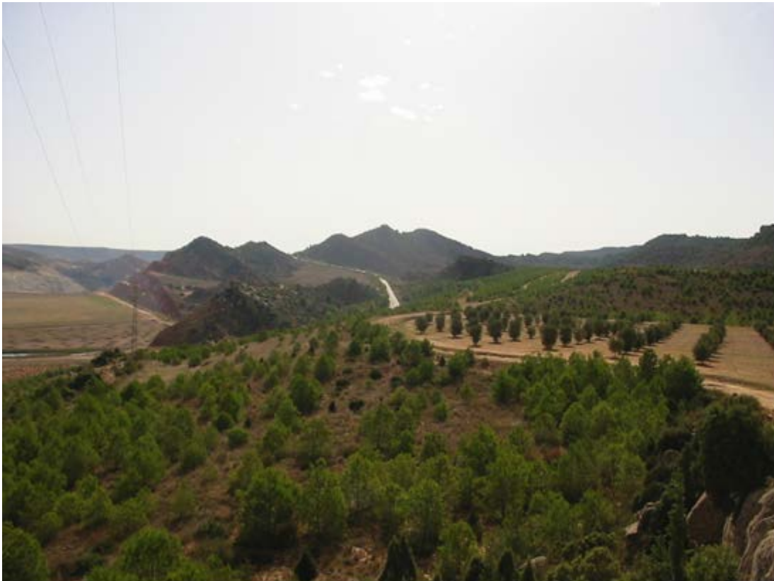
Restauraciones de la escombrera de la Corta Barrabasa (Alloza)
