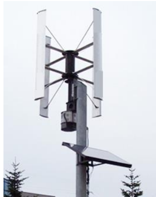
Figura 9. Microturbina d'eix vertical amb el generador i el panell fotovoltaic instal·lat.
