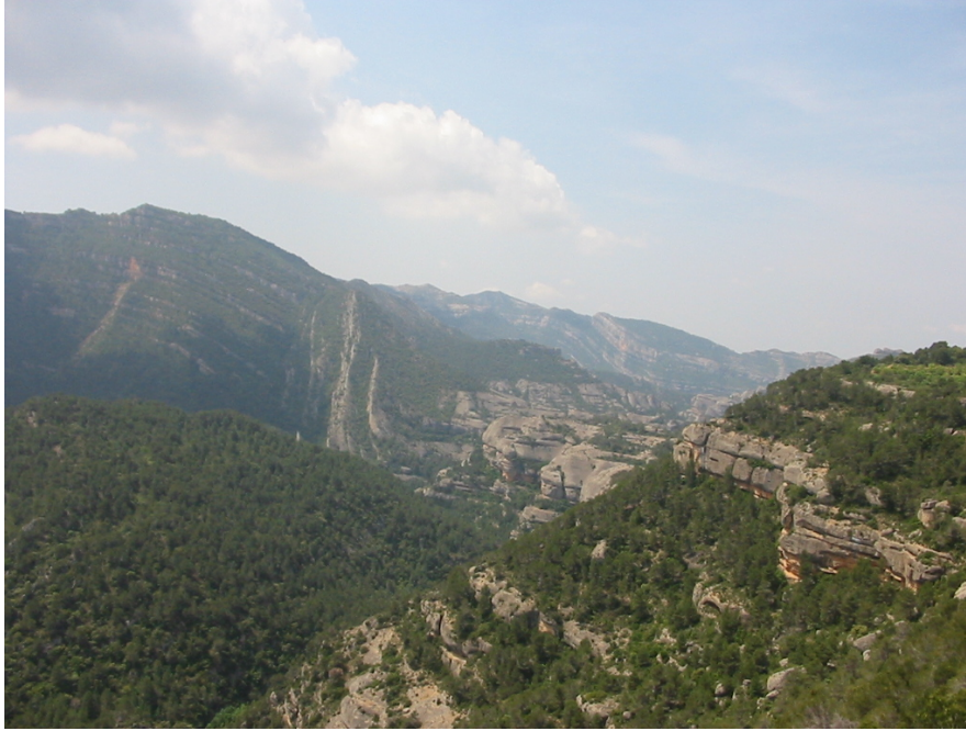
Fotografia 4. Aspecte de la Flexura del Montsant
