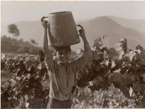
2. Transportando o sulfato
