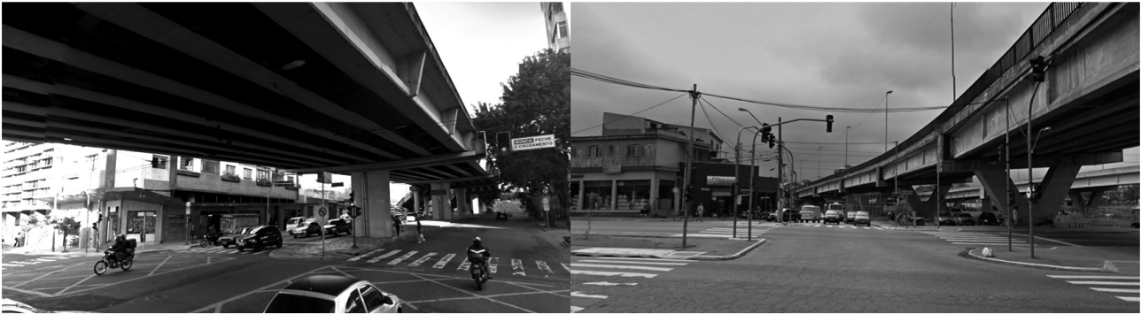
Elevado Costa e Silva na região central e implantação da Avenida Jacu Pêssego na zona leste de São Paulo. Elaboração própria sobre Google Street View .
