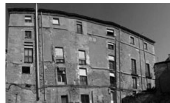
LA FACHADA ANTES DE LA INTERVENCIÓN.
