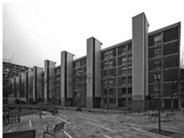
VISTES EXTERIOR DELS NOUS MÒDULS D'ASCENSOR A LA MINA VELLA.
