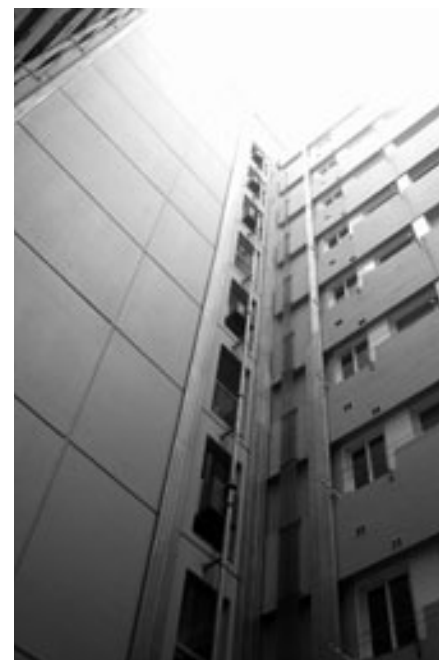
NOVES INSTAL·LACIONS EN EL PATI DEL MÒDUL REHABILITAT INTEGRALMENT.
