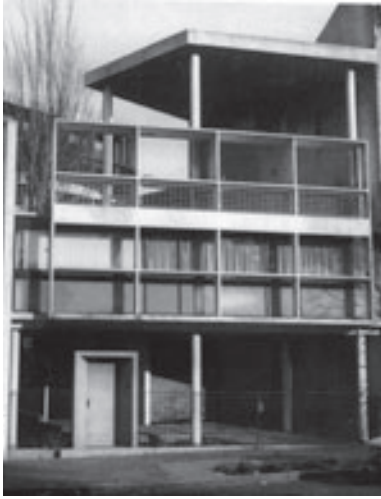
LA REGULACIÓN DE LA RADIACIÓN SOLAR MEDIANTE EL BRISE-SOLEIL Y EL BALDAQUÍN EN LA CASA CURUTCHET, CIUDAD DE LA PLATA, ARGENTINA, LE CORBUSIER, 1949
