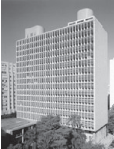
REGULACIÓN DE LA RADIACIÓN SOLAR MEDIANTE LAMAS MÓVILES EN EL EDIFICIO PARA EL MINISTERIO DE EDUCACIÓN Y SALUD, RÍO DE JANEIRO (LUCIO COSTA Y EQUIPO, 1936-1945)
