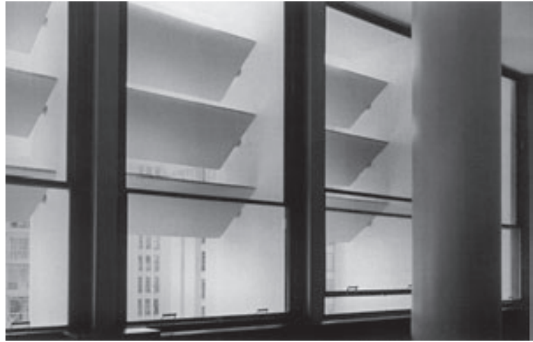
REGULACIÓN DE LA RADIACIÓN SOLAR MEDIANTE LAMAS MÓVILES EN EL EDIFICIO PARA EL MINISTERIO DE EDUCACIÓN Y SALUD, RÍO DE JANEIRO (LUCIO COSTA Y EQUIPO, 1936-1945)
