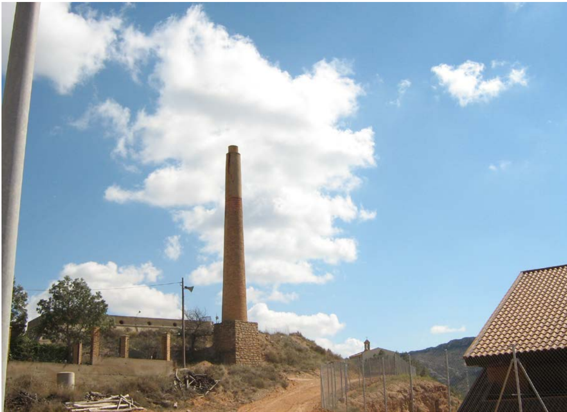
Fotografía 4. La chimenea de la antigua tejera
