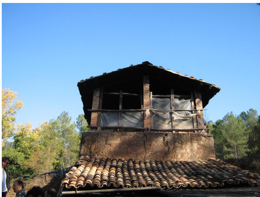
FOTOGRAFIA 9 (PARADA 8) Aspecte frontal de la Teuleria de Can Barraquer
