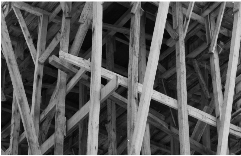
▲ Fig.1 Encofrado típico de tablas en Argentina. Foto Fernando Diez
