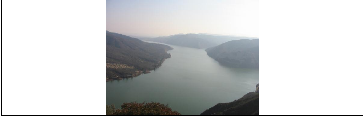
FOTOGRAFÍA 1. Zona de confluencia ( aiguabarreig ) entre el río Matarraña (derecha) y río Ebro (izquierda), en el embalse de Riba-roja PHOTO 1. Confluence area ( aiguabarreig in Catalan) between Matarraña River (right) and Ebro River (left), in the reservoir of Riba-roja
