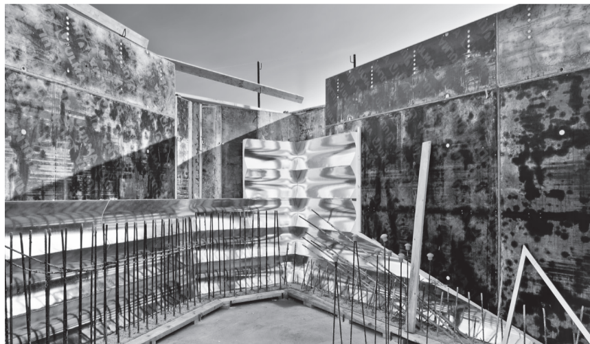
Encofrado de pórex con recubrimiento de aluminio
