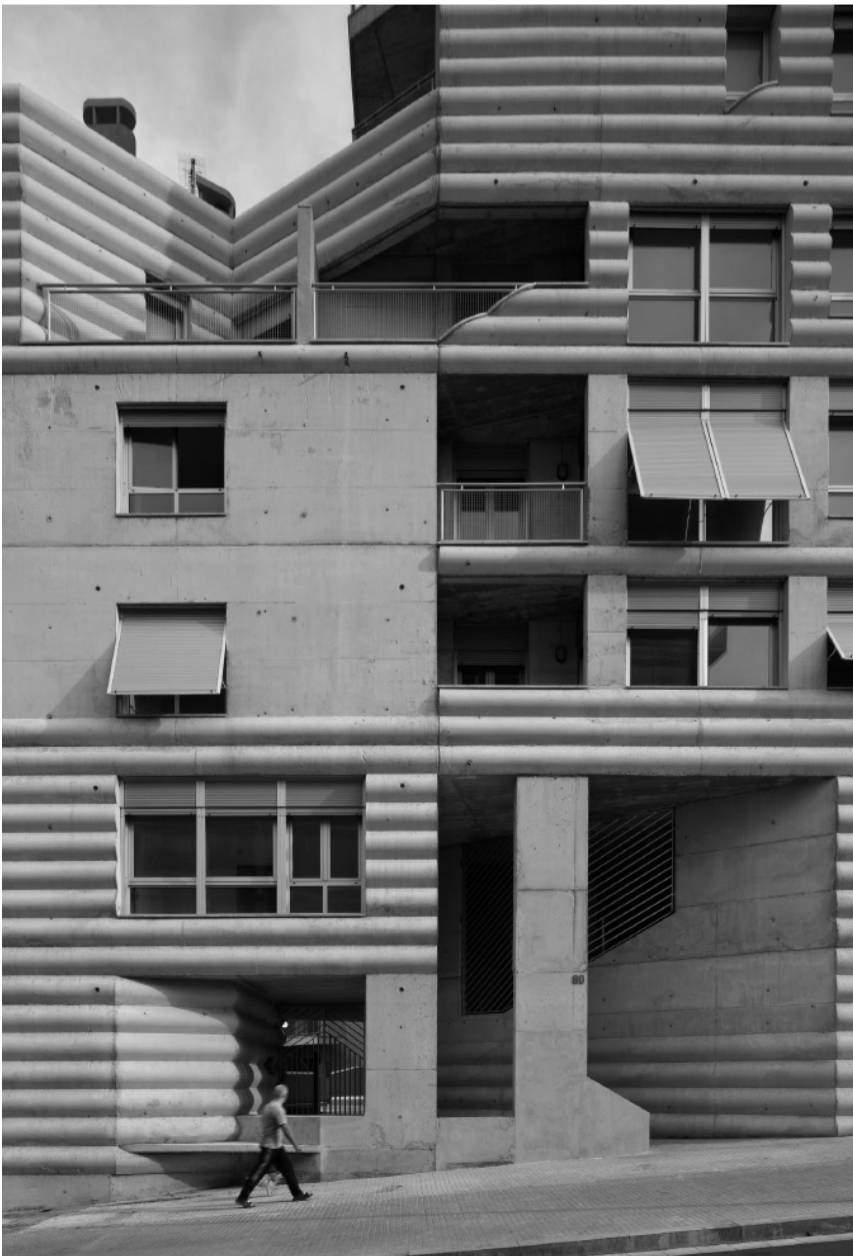
Entrada principal al edificio
