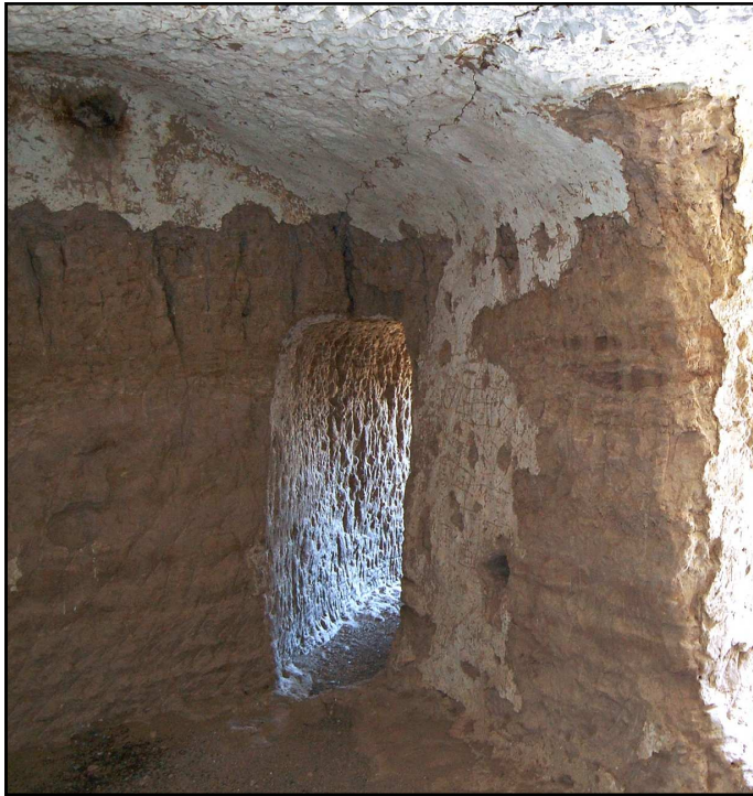
Entrada al Aljibe de tapial de los Algarves. (Gorafe). Granada
