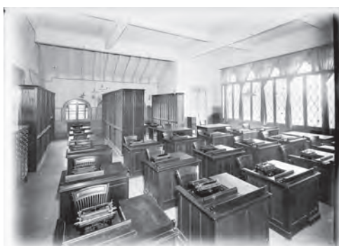
4 SEDE DE LA EMPRESA NORTEAMERICANA R.G. DUN & CO. EN EL CUARTO PISO DEL CASAL DEL ESTALVI. LA ESTRUCTURA DE HORMIGÓN ARMADO DE LA CUBIERTA QUEDA VISIBLE EN LOS ESPACIOS ALQUILADOS. [FONDO BRANGULÍ, ANCI-42-N-9459, ANC].
