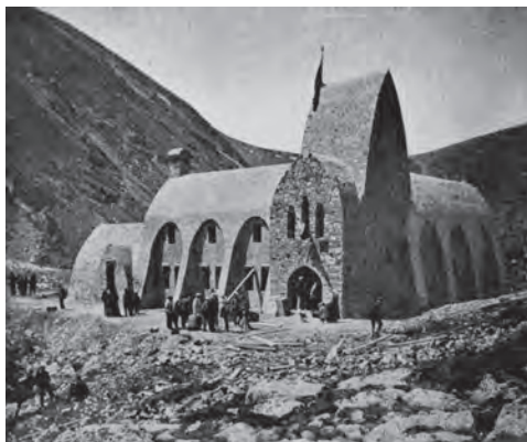
1 EL CHALET-REFUGIO DEL CENTRE EXCURSIONISTA DE CATALUNYA EN ULL DE TER, OBRA DE JERONI MARTORELL (1909). [BUTLLETÍ DEL CEC, 175, BIBLIOTECA DE CATALUNYA].
